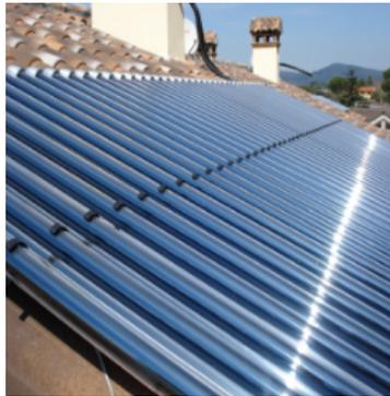
Figura 10: Esempio di collettori heat-pipe installati ad uso privato. [8]
