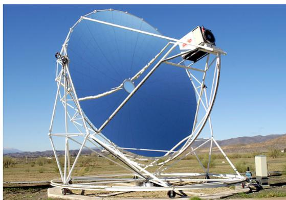
Figura 14: Fotografia di un parabolic dish solar concentrator in funzione [12].
