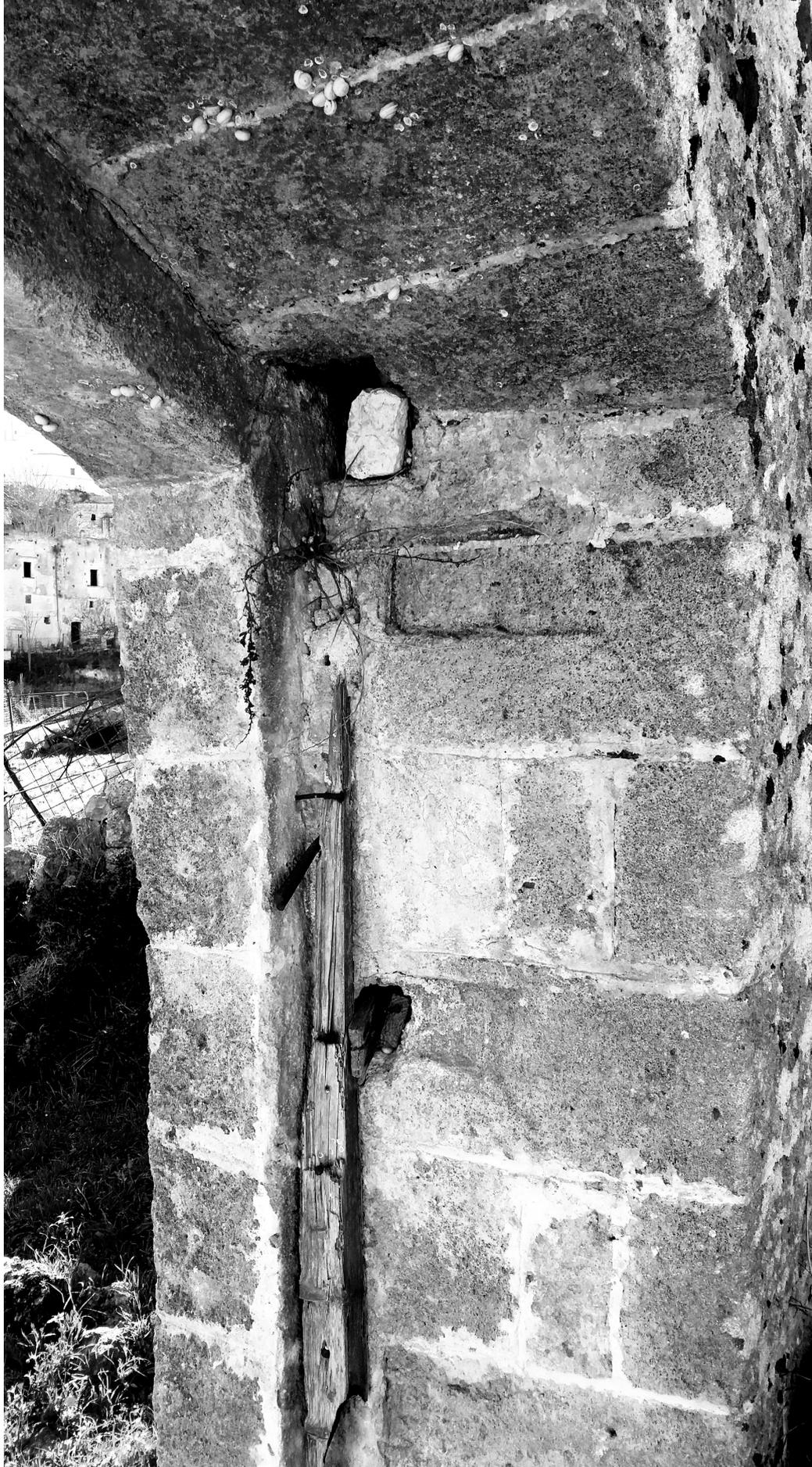
Figura 17: foto dello stipite di una porta con foro di alloggiamento del telaio ligneo. Foto dell'autore, 20/01/2018;
