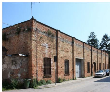
7.2 Prospetto dell'edificio n°3, l'unico dei tre edifici non intonacato e con muratura in filari di mattoni facciavista.
