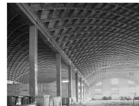
1.1 Interni del capannone in cemento armato; particolare delle volte in laterizi caratterizzate da un leggero reticolo di nervature.
