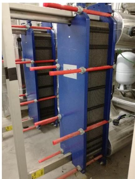
Figura 17 Scambiatori a piastre installati presso Maison Lostan
