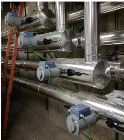
*Figura 23 Valvole a 3 vie con servomotore elettrico per la commutazione dei circuiti provenienti dalle pompe di calore*
