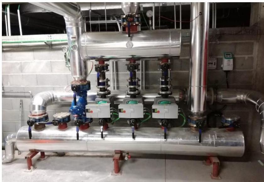
*Figura 24 Collettore caldo e pompaggi primari*
