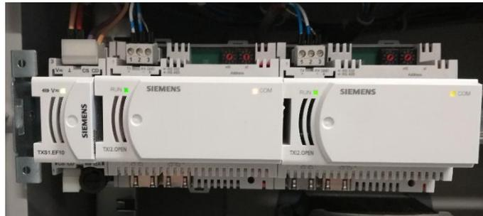
*Figura 31 Moduli TXI2.OPEN per l'integrazione delle pompe di calore e delle pompe di circolazione via Modbus.*
