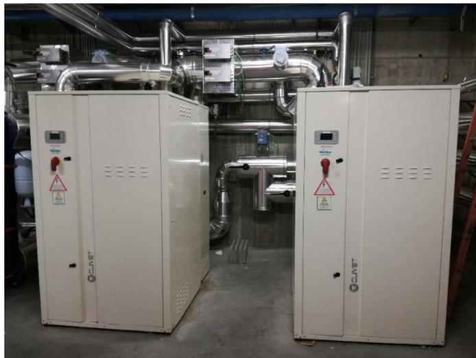
Figura 18 Pompe di calore installate presso Maison Lostan
