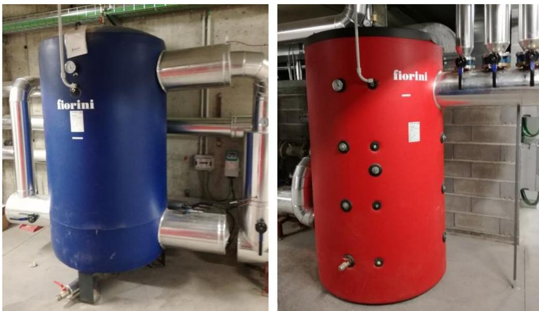
*Figura 22 A sinistra: serbatoio di accumulo freddo con in alto a destra il ritorno dal collettore delle utenze e in basso i due ritorni verso le pompe di calore. A destra: serbatoio di accumulo caldo con in basso a sinistra l'ingresso per l'acqua di ritorno dalle utenze. In alto a destra le uscite verso la pompa di calore 1, la pompa di calore 2 e il circuito comune di recupero.*
