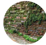
presenza di umidità e infiltrazioni d'acqua.
