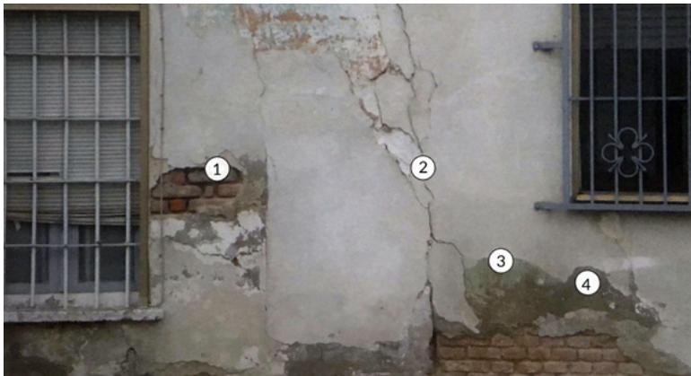
**Figura 5.3** problemi di intonaco degradato.<sup>e</sup>
