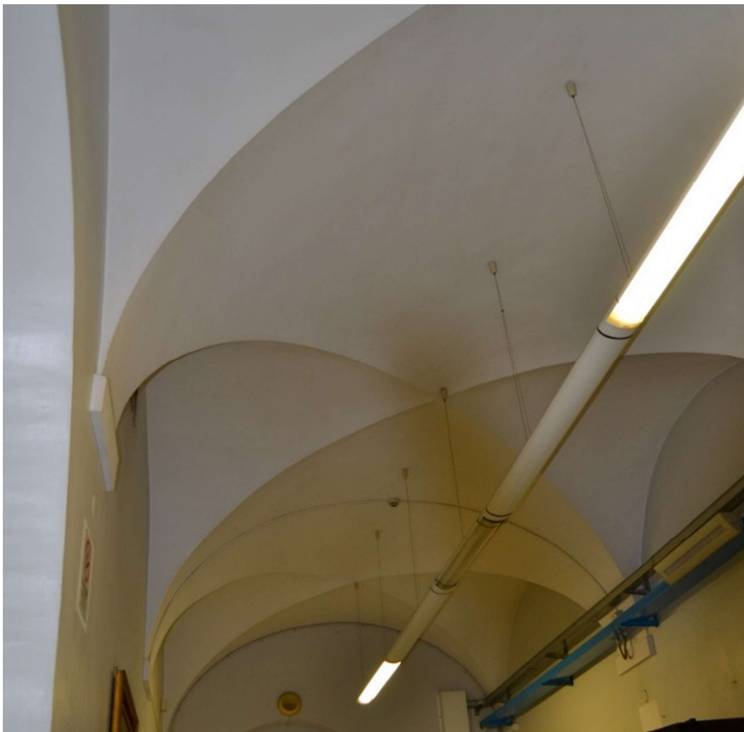
Figura 46 – Volte a crociera all' ingresso del secondo piano dell' edificio
