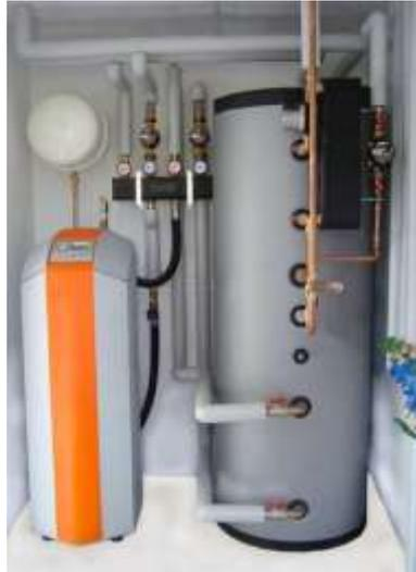
*Figura 29: A sinistra pompa di calore e a destra serbatoio di accumulo con tubazioni e valvole*
