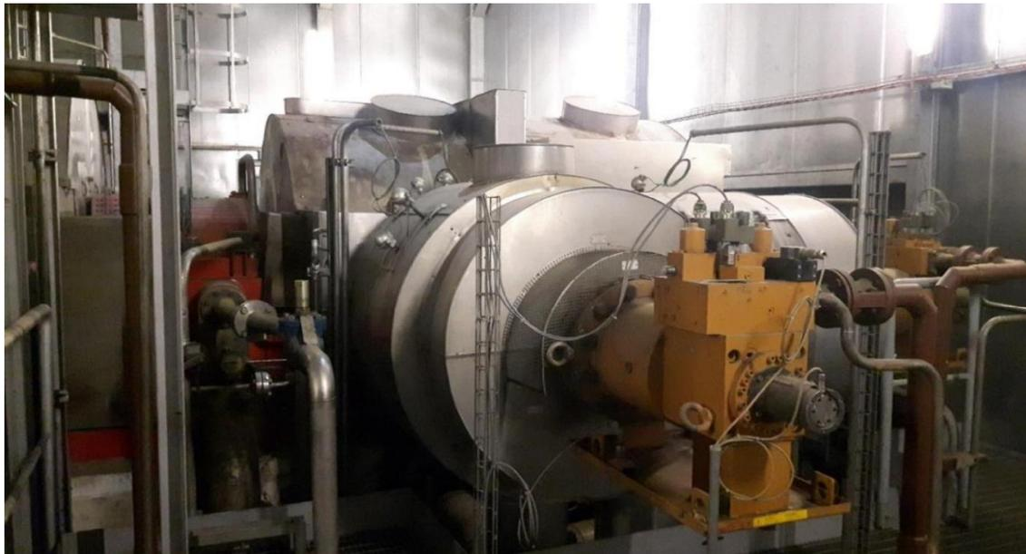
*Figura 1.8 Sezione turbina a vapore di alta pressione*
