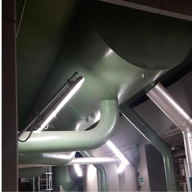
*Figura 1.9 Condensatore*
