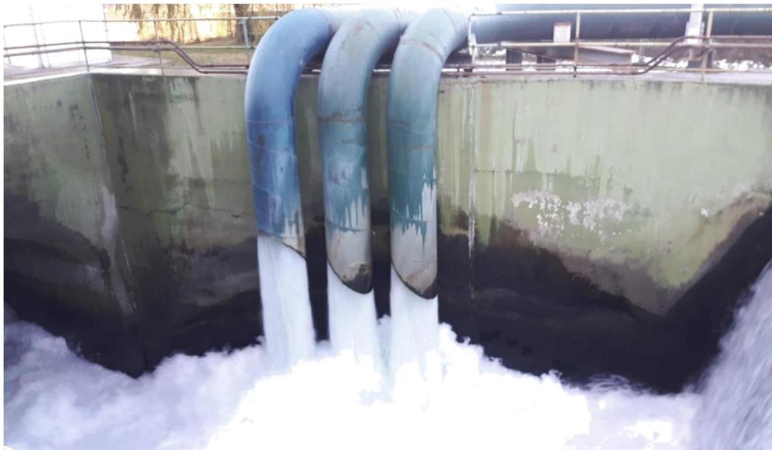
*Figura 1.11 Scarico dell'acqua del condensatore nel canale*
