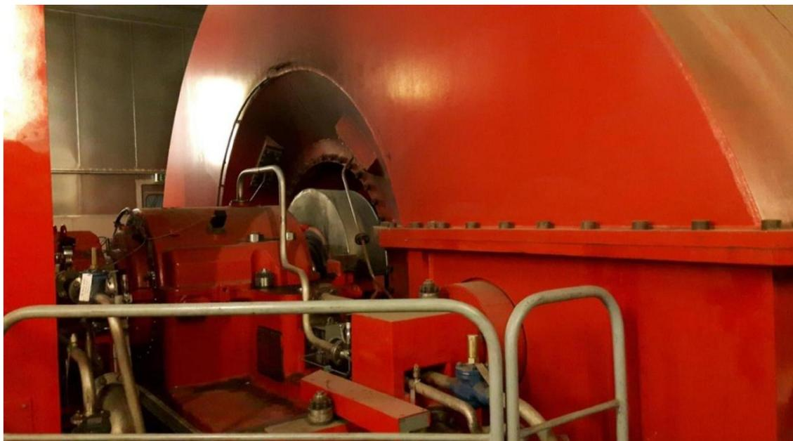
*Figura 1.6 Sezione turbina a vapore di bassa pressione*
