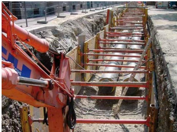
*Fig. 11 Posa della rete di teleriscaldamento. Fonte [21]*
