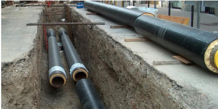
Figura 18: Posa delle tubazioni di una rete di teleriscaldamento (22)
