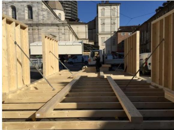
Figura 4.2: Realizzazione e montaggio del modulo
