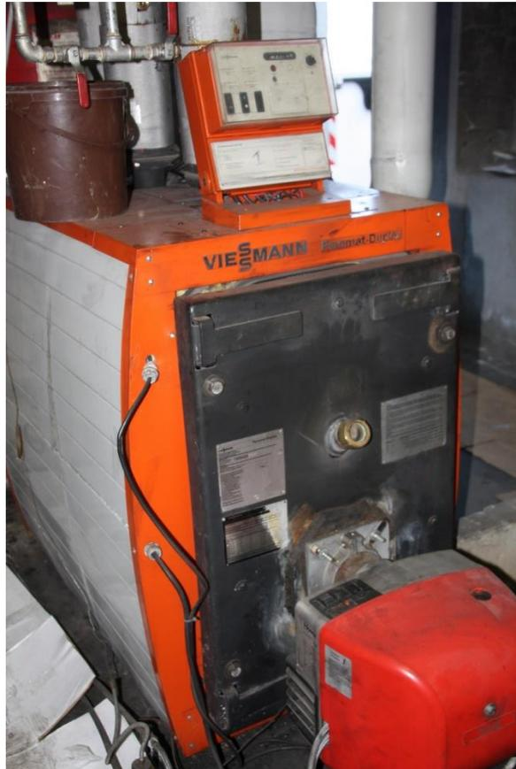
*Figure 17 Caldaia a gasolio da 116 kW*
