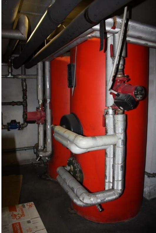
*Figure 19 Accumuli termici per la produzione di ACS*
