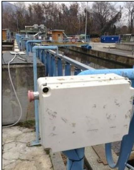
*Figura 34: Dispositivo di arresto di emergenza.*
