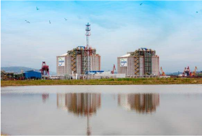
Figure 4: El Musel LNG storage tanks [9]
