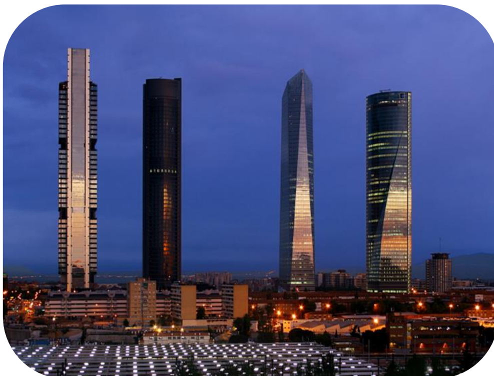
Fig. 45 Cuatro Torres Business Area [FHECOR Ingenieros Consultores]
