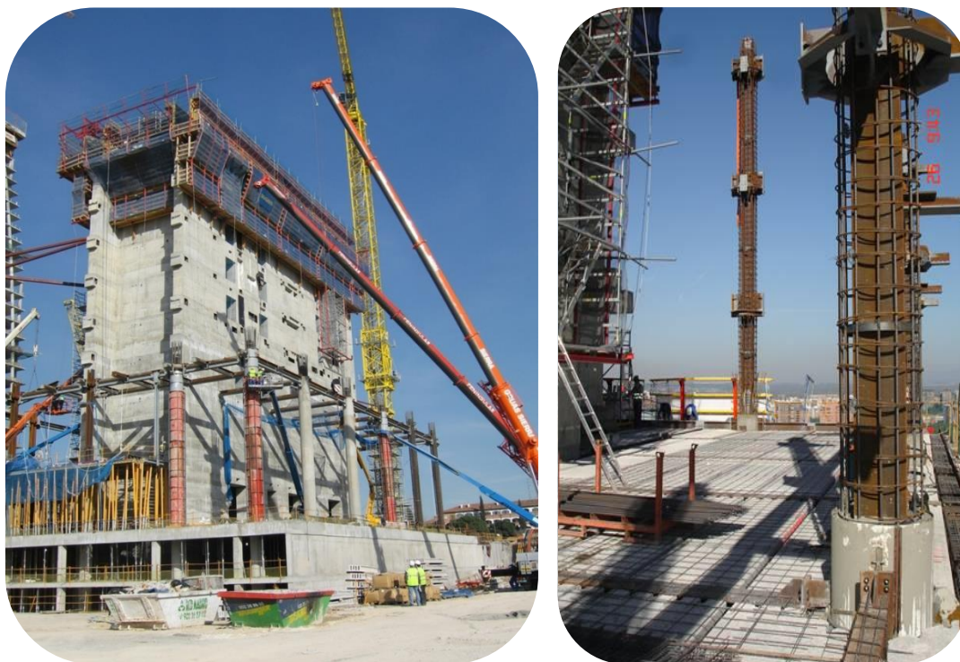
Fig. 56 Costruzione del nucleo in anticipo di quattro livelli (sinistra), costruzione delle mega colonna (destra) [38, FHECOR]
