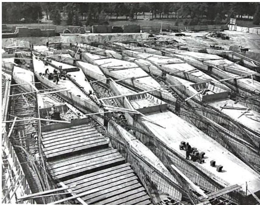
*Figura 13 - Casseratura dei solai in latero-cemento*
