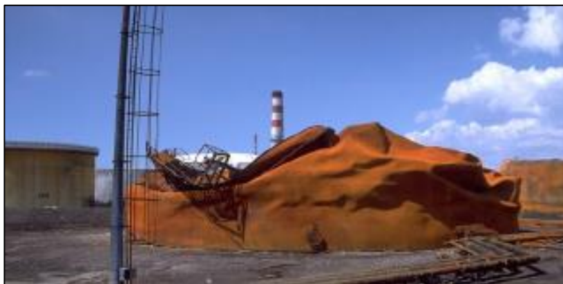
Figura 3.6.3 - Serbatoio post incendio
