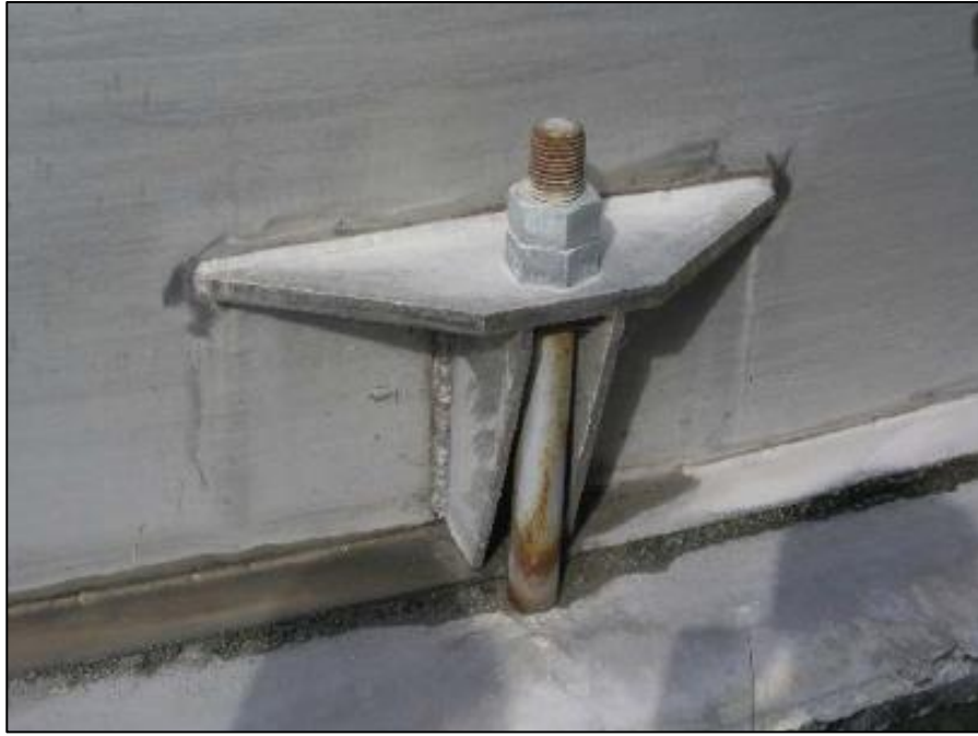
Figura 3.4.9 - Esempio di ancoraggio
