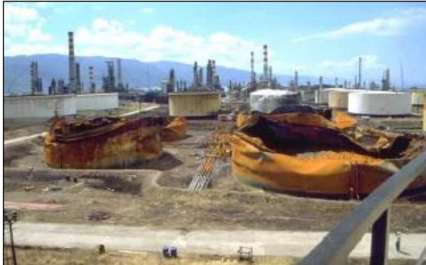
Figura 3.4.13 - Effetto di incendi nei serbatoi
