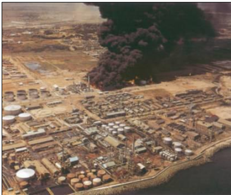
Figura 3.6.10 – Incendio in seguito al terremoto in Giappone 1964
