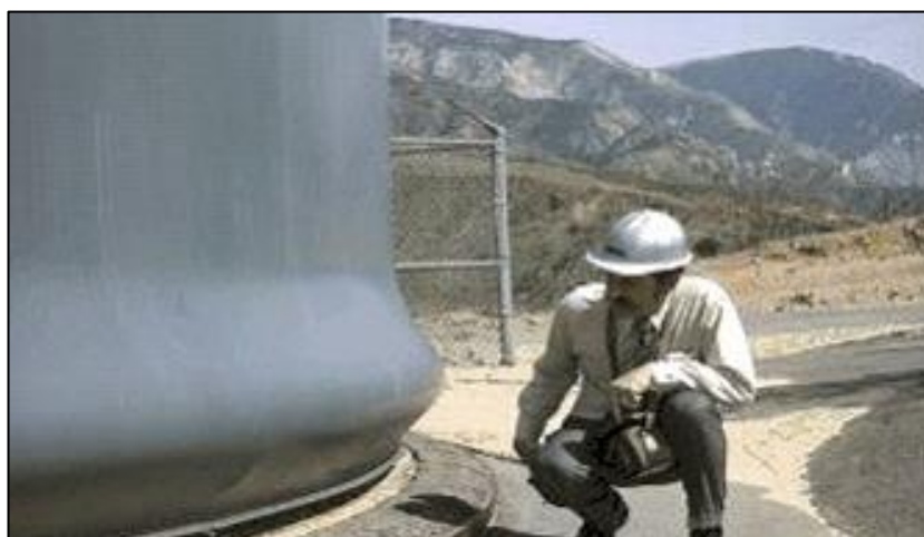
Figura 3.4.2 – Esempio di instabilità elasto-plastica molto pronunciata
