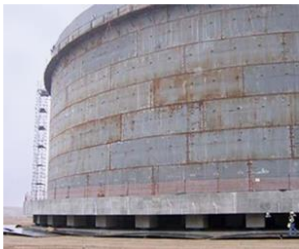
Figura 7.1.1 – Serbatoio isolato con dispositivi a pendolo scorrevole
