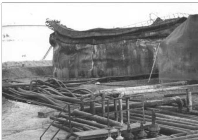
Figura 3.1.1 – Esempio di danneggiamento di un serbatoio
