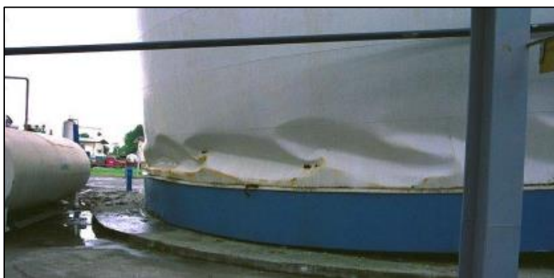
Figura 3.4.6 – Deformazione a “diamante”
