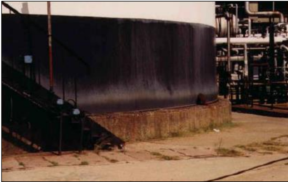
Figura 3.4.3 - Esempio di instabilità elasto-plastica lieve
