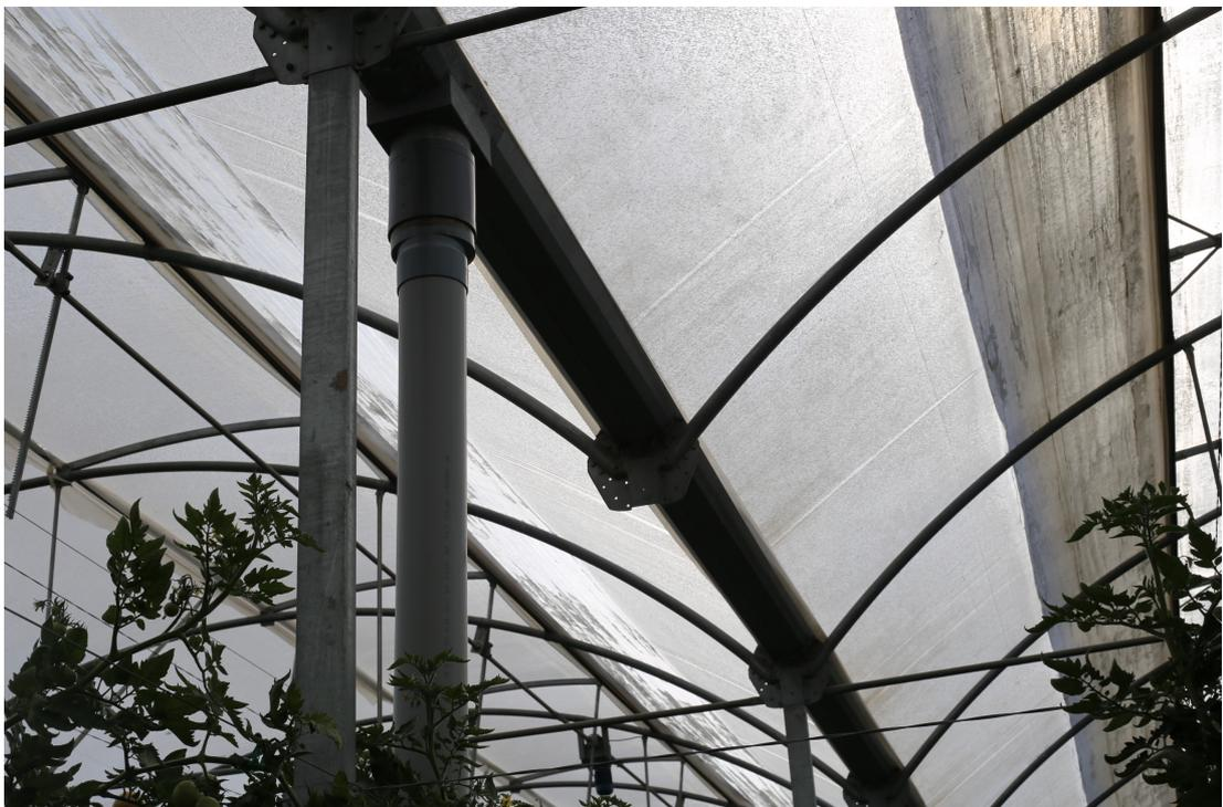
*Figura 4.3: Particolare strutturale del RWH in serra multitunnel. Proprietà Escobar Reyes, Las Norias de Daza. (Catalán Mulero, M. 2018) (Elaborazione propria)*
