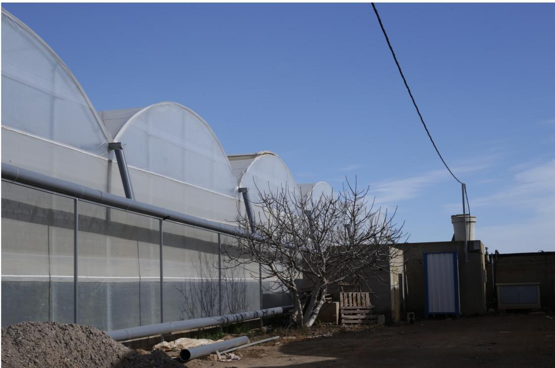
*Figura 4.1: Sistema di RWH installato su serra multitunnel. Proprietà Escobar Reyes, Las Norias de Daza. (Catalán Mulero, M. 2018) (Elaborazione propria)*
