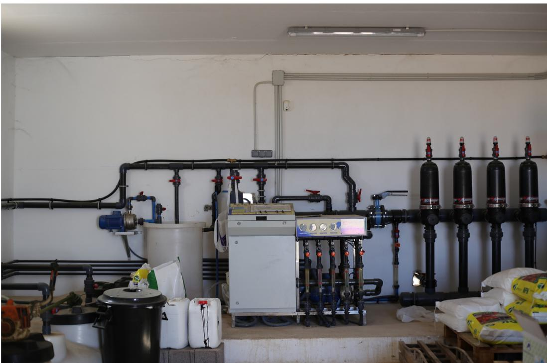
Figura 4.8: Sistema di pompaggio idrico per irrigazione. Proprietà Escobar Reyes, Las Norias de Daza. (Catalán Mulero, M. 2018)
