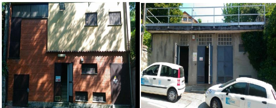
Fig. 3.15 Ingresso impianti San Bartolomeo e Revigliasco
