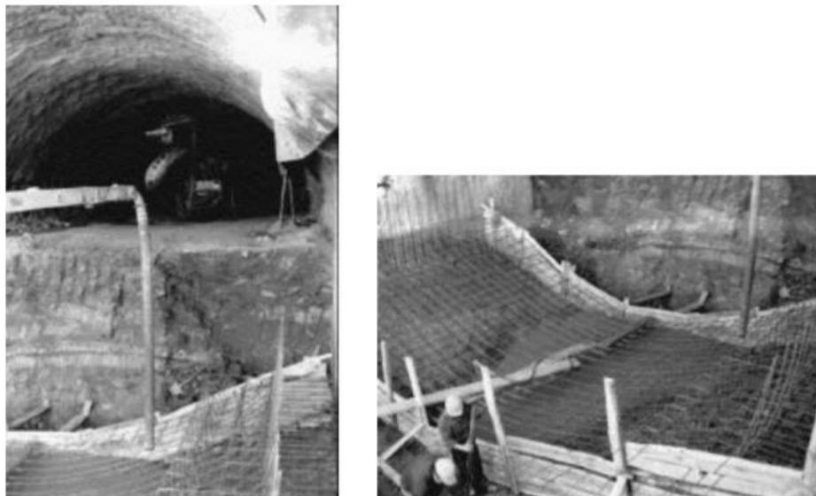
Figura 2.10 – Scavo con calotte e ribasso, posizionamento del rinforzo in acciaio nel ribasso, S. Ambrogio tunnel lungo autostrada Palermo-Messina in Italia
