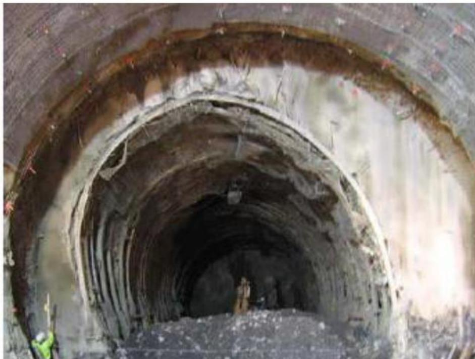
Figura 2.25 – Scavo di St. Martin La Porte, è possibile osservare le grandi deformazioni del bordo scavo e come il supporto riesca a deformarsi con esso, convergenza di circa 2 m
