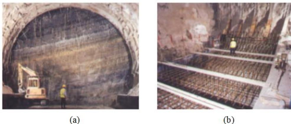
Figura 2.13 – Scavo a piena sezione, Tartaiguille tunnel, in Francia: a) foto del fronte; b) foto del supporto dell'arco rovescio (Lunardi et al., 2000)
