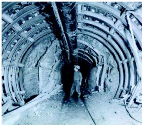
**Figura 2.1 – Comportamento spingente osservato nella galleria del Gottardo: il fenomeno è dovuto al raggiungimento di stati tensionali che superano il valore limite per cui si innescano deformazioni dipendenti dal tempo (Barla, 2008)**
