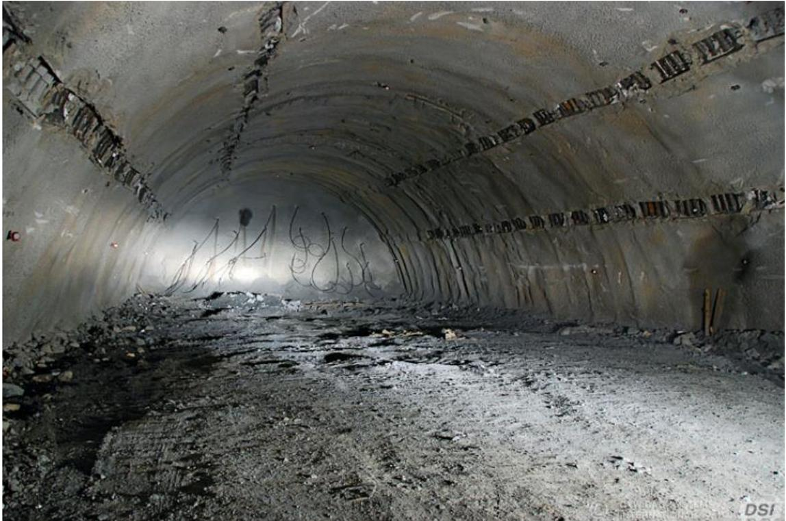
Figura 2.18 – Elementi cedevoli in acciaio installati negli slot del rivestimento ed elementi LSC, Metsovo Tunnel in Grecia, (Dywidag-Systems International)
