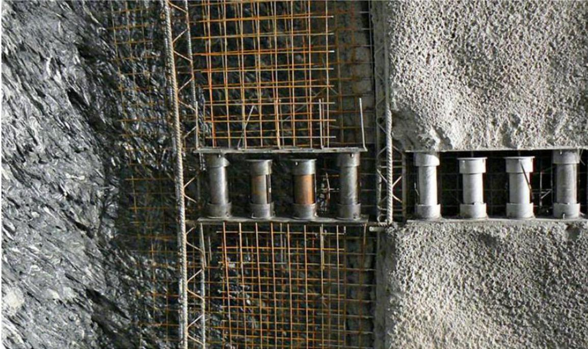
**Figura 2.20 – Installazione degli elementi LSC tra i segmenti del rivestimento, Tauern Tunnel in Austria (Dywidag-Systems International)**
