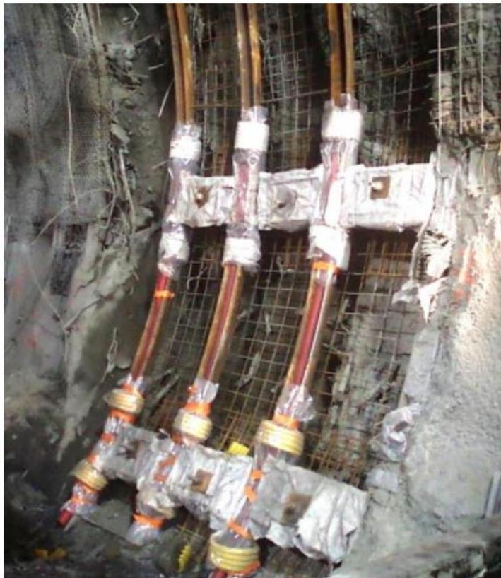
Figura 2.23 – Foto di dettaglio durante l'installazione degli elementi HDC, tunnel di St. Martin La Porte
