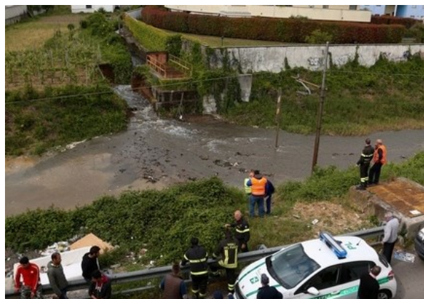
Figura 2.5: Allagamento sede ferroviaria a Vigevano
