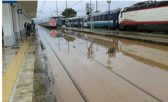
Figura 2.6: Allagamento sede ferroviaria in Puglia
