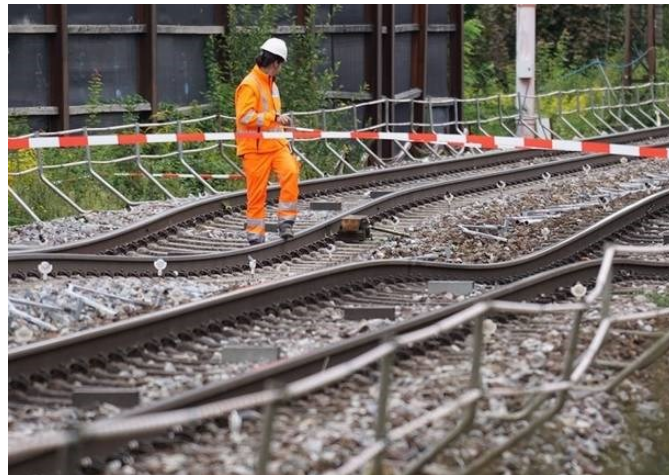
Figura 3.2: Cedimento sottovia stradale in Germania
