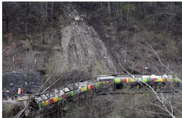
Figura 2.3: Incidente ferroviario – Frana in Valvenosta
