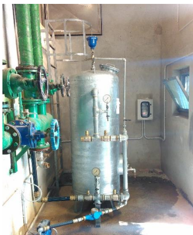
Figura 5.2: Impianto a resine in località 2
