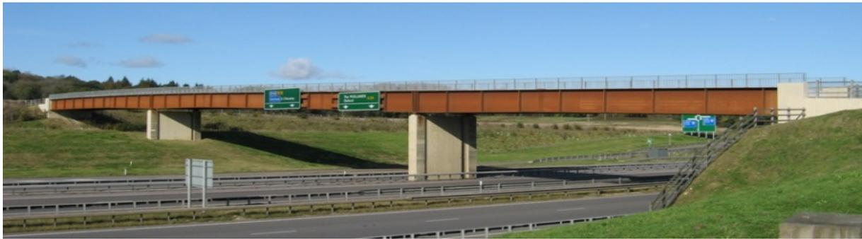
**Figura1.30:** ponte con campate in acciaio corten a Kiev.
