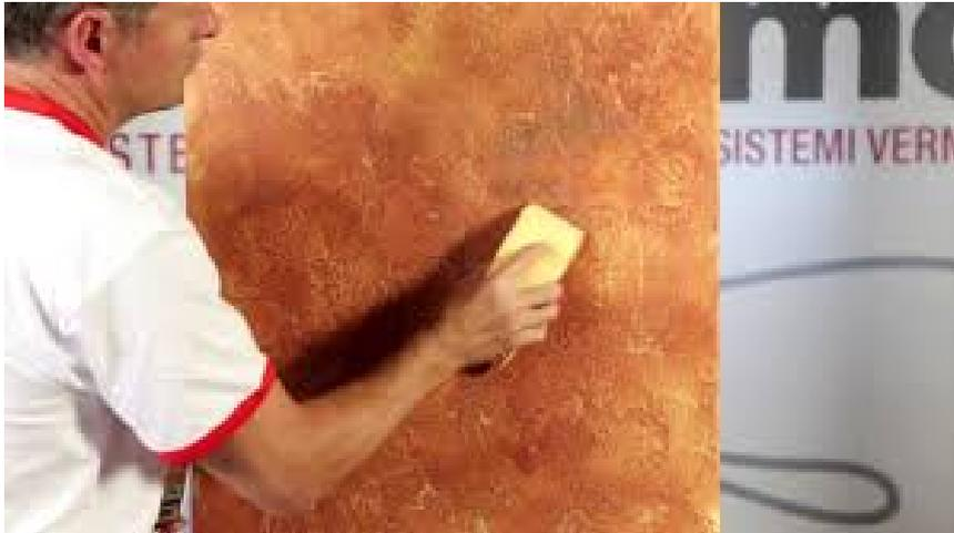
**Figura 1.28:** sistema polimerico in grado di imitare, nello stile, la superficie del Corten
