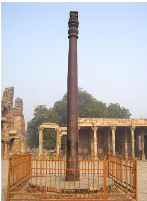
**Figura1.35:** la Delhi Iron Pillar nella sua interezza e bellezza. Questo oggetto in ghisa, similmente agli acciai corten, presenta tenori di fosforo e rame più alti della norma, probabilmente causati da un'errore durante i processi di produzione. Tale caratteristica ha permesso alla colonna di conservarsi allo stato metallico -e non ossidato- esposto alle intemperie del clima monsonico di Delhi per 1600 anni fino ad oggi [31][30].
