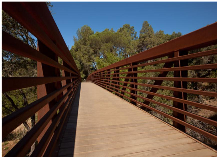
**Figura1.29:** ponte in acciaio corten in Nebraska.
