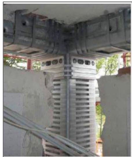
**Figura 26-Sistema CAM per edifici in c.a.**
