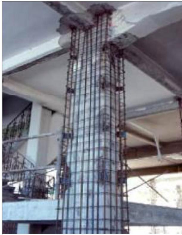
**Figura 29-Rimozione elementi circostanti al pilastro**
