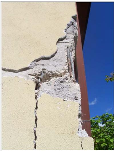
Figura 4-Lesione pseudo-orizzontale nell'attacco pilastro-pannello
