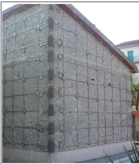
**Figura 25-Sistema CAM per edifici in muratura**
