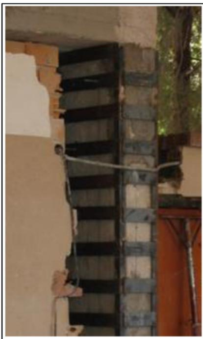
Figura 21-Esempio di applicazione del rinforzo con l'impiego di malta
