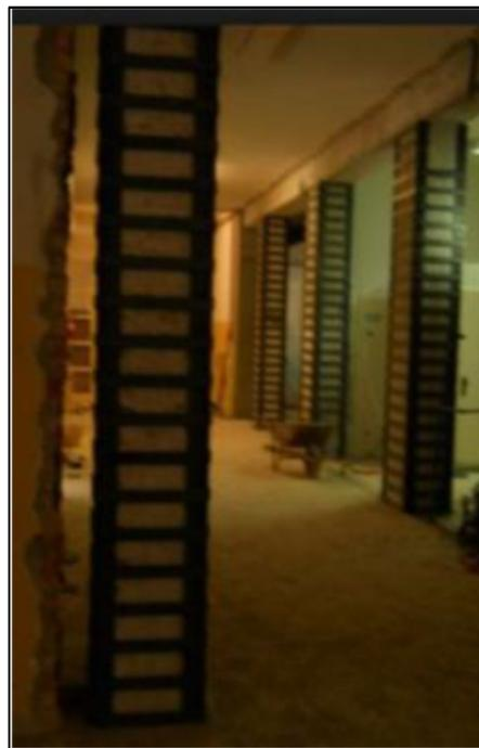
Figura 22-Esempio 2 di applicazione del rinforzo con l'impiego di malta
