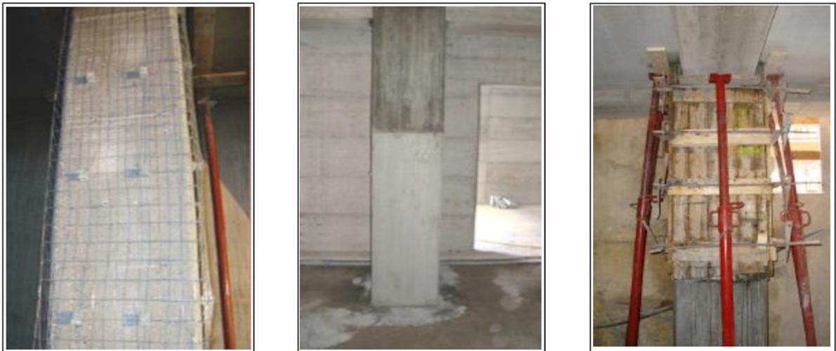
Figura 42- Successione delle fasi dell'incamiciatura con HPFRC
