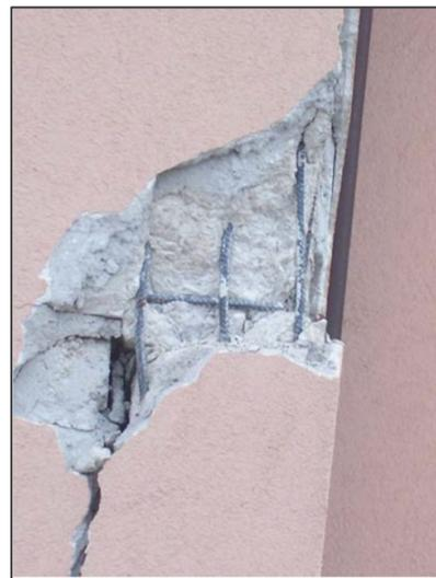
Figura 7-Particolare nodo trave-pilastro
