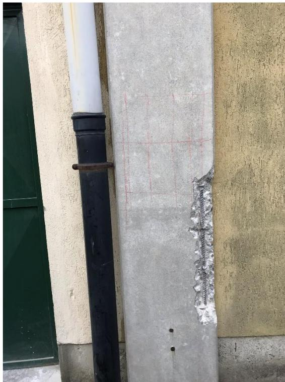
*Figura 62 Individuazione profilato d'acciaio, colonna tipo C, armata con  $6\phi 18$*
