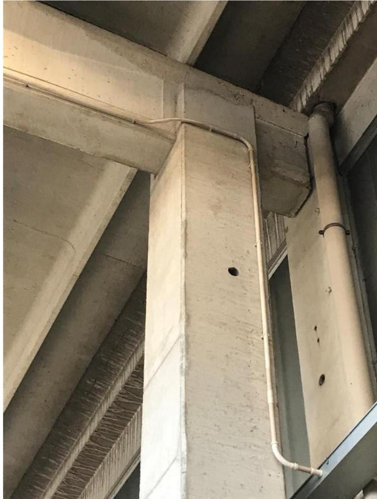
*Figura 45 Collegamento trave pilastro*
