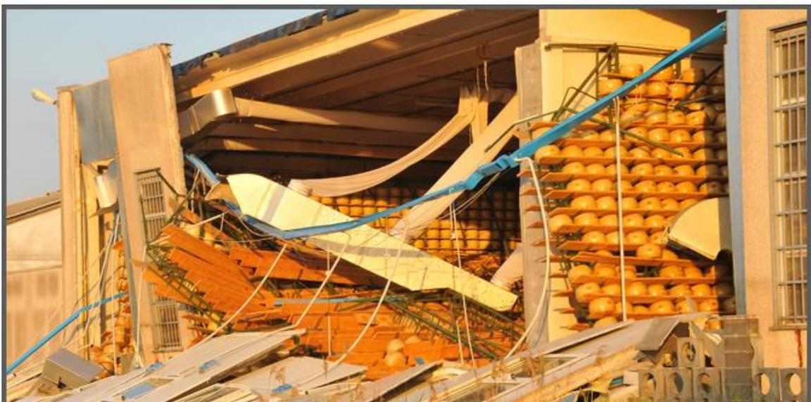
*Figura 19 Collasso di elementi strutturali dell'edificio industriale e di scaffalature interne.*
