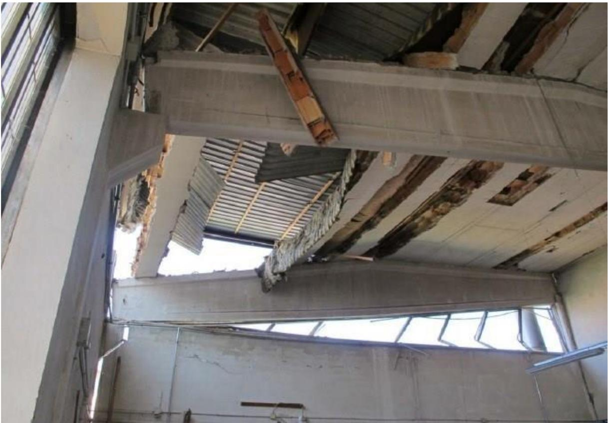
*Figura 15 Perdita d'appoggio trave principale di una struttura monopiano prefabbricata*
