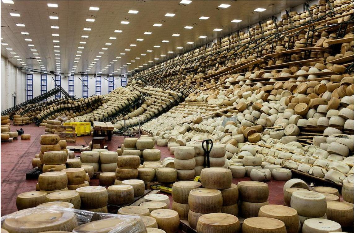
*Figura 18 Collasso di scaffalature in un edificio industriale a seguito delle scosse subito*
