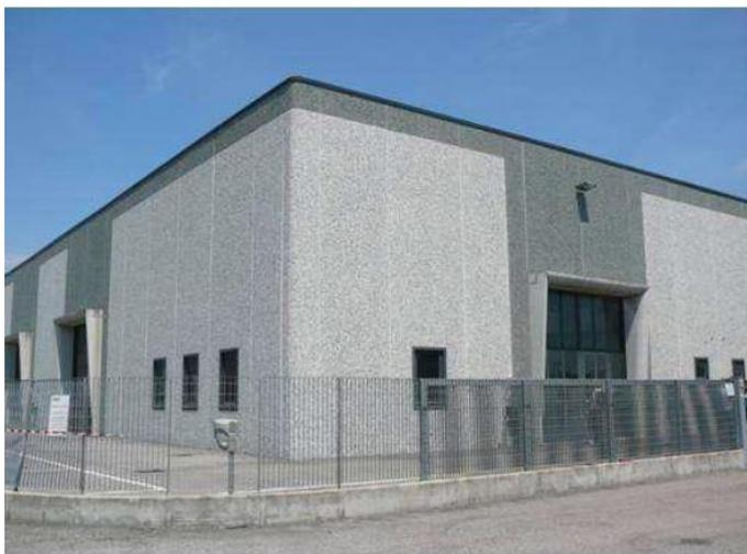
*Figura 8 Tamponamento con pannelli prefabbricati verticali*
