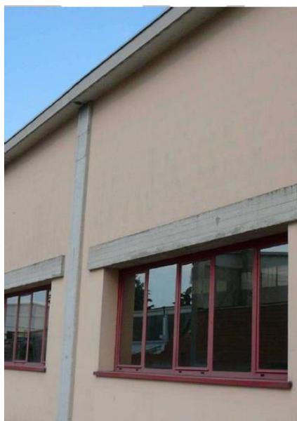
*Figura 10 Tamponamento con muratura in laterizio*
