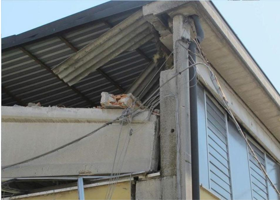
*Figura 16 Dettaglio del collasso di una trave di un edificio industriale*
