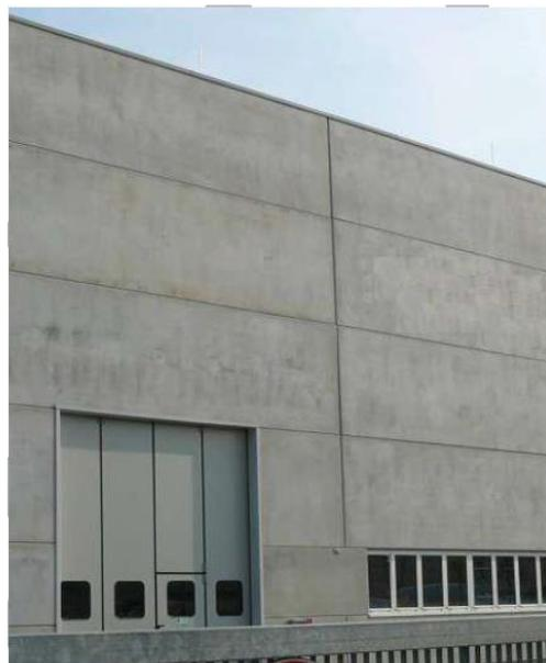
*Figura 9 Tamponamento con pannelli prefabbricati orizzontali*
