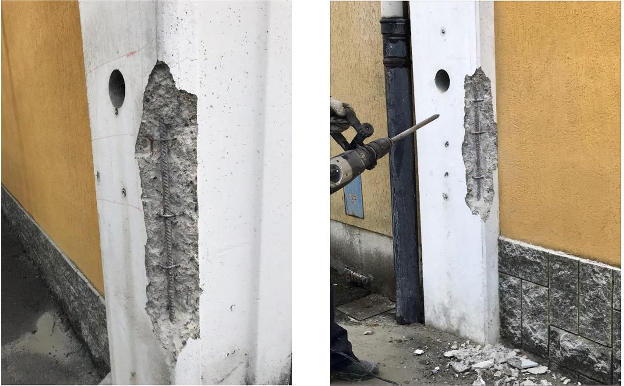
*Figura 61 Individuazione dei profilati d'acciaio, a sinistra in evidenza la colonna tipo Asx, a destra la colonna tipo B, caratterizzati da  $2\phi 16$*
