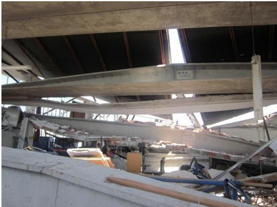
*Figura 17 Collasso dei tegoli di copertura di una struttura monopiano prefabbricata*
