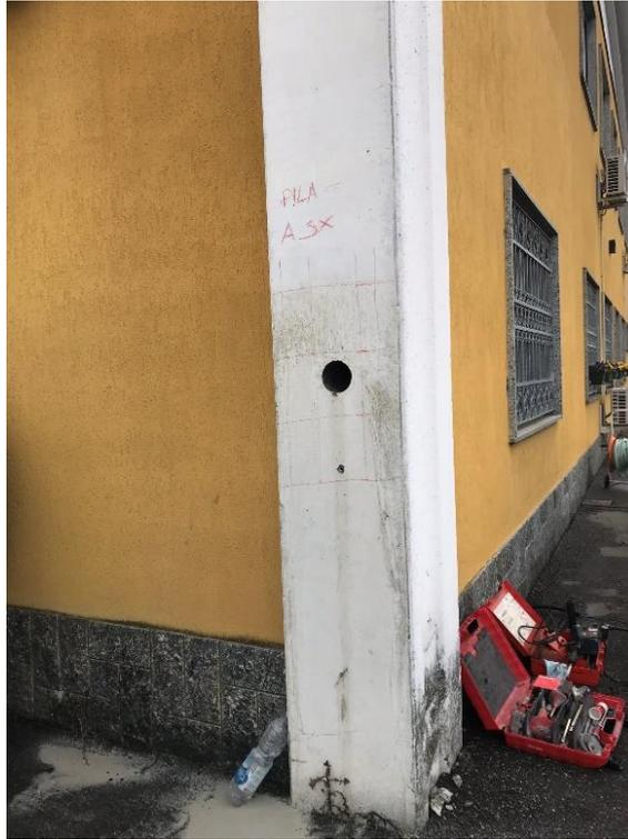
*Figura 56 Colonna a seguito del carotaggio, elemento tipo Asx dell'edificio 1*
