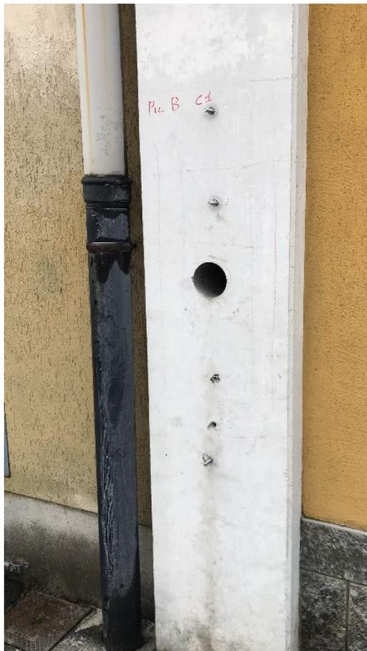
*Figura 57 Colonna tipo B, edificio 1 a seguito del carotaggio.*
