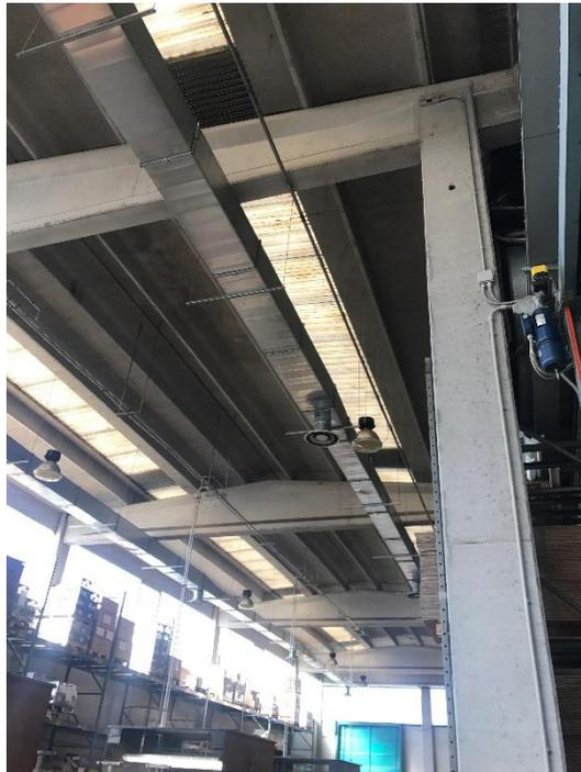
Figura 44 Rilievo fotografico di pilastri e travi prefabbricate
