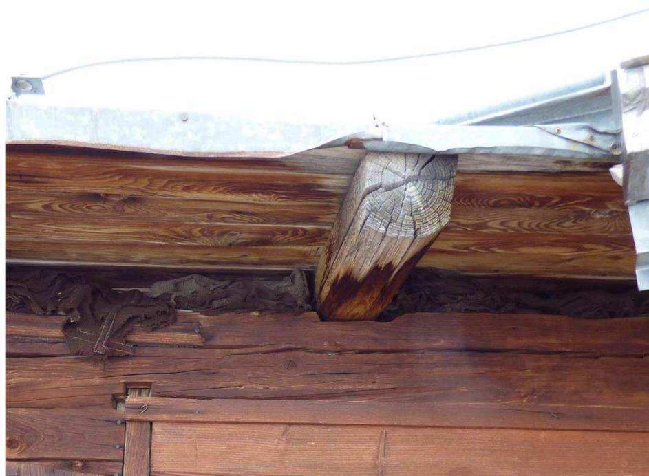
*Figura 36- stato di conservazione trave del tetto*
