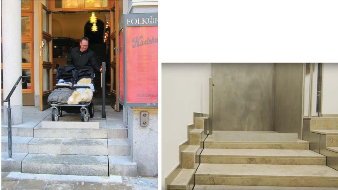
**Figura 29 - Modello C piattaforma elevatrice [11]**
