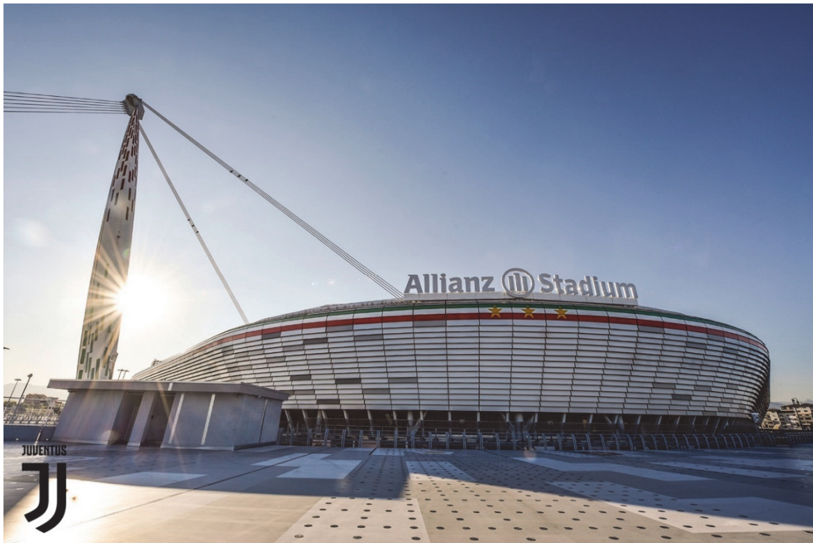
Figura 9 – Foto panoramica esterna in cui si illustra la particolarità del rivestimento di facciata a pannelli e i pennoni che reggono la copertura dello stadio. (fonte: www.Juventus.com ).
