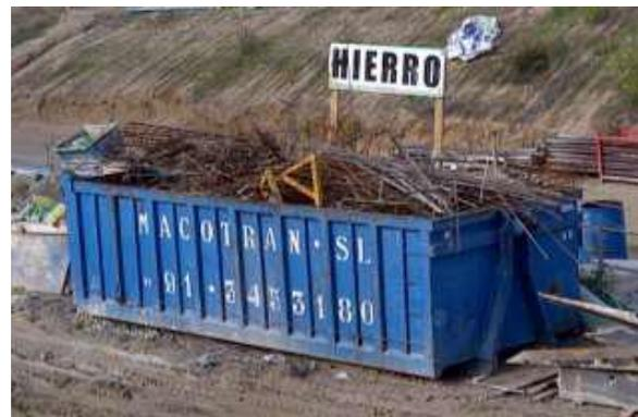
Figura 15. Contenitori metallici RCD valorizzabili, NEINOR 76.
