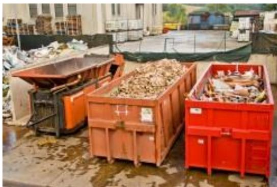
Figura 5. Esempio di separazione selettiva e deposito temporaneo ([www.asarva.org](http://www.asarva.org)).
