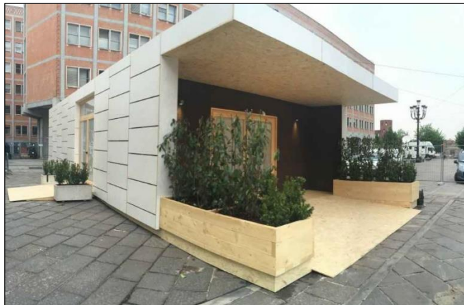
Figura 1.2 Struttura in cui saranno realizzate le due sale.
