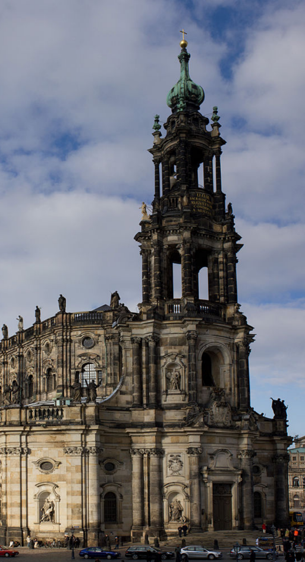
Fig. 104: Katholische Hofkirche, Dresden, veduta prospetto principale Fonte: https://de.wikipedia.org/wiki/ Katholische_Hofkirche Consultazione: 27 Gennaio 2018
