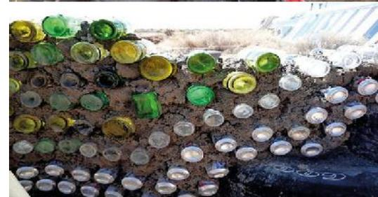
*Earthship, strutture murarie realizzate con pneumatici e bottiglie di vetro, uniti da terra, intonaco e argilla.*
