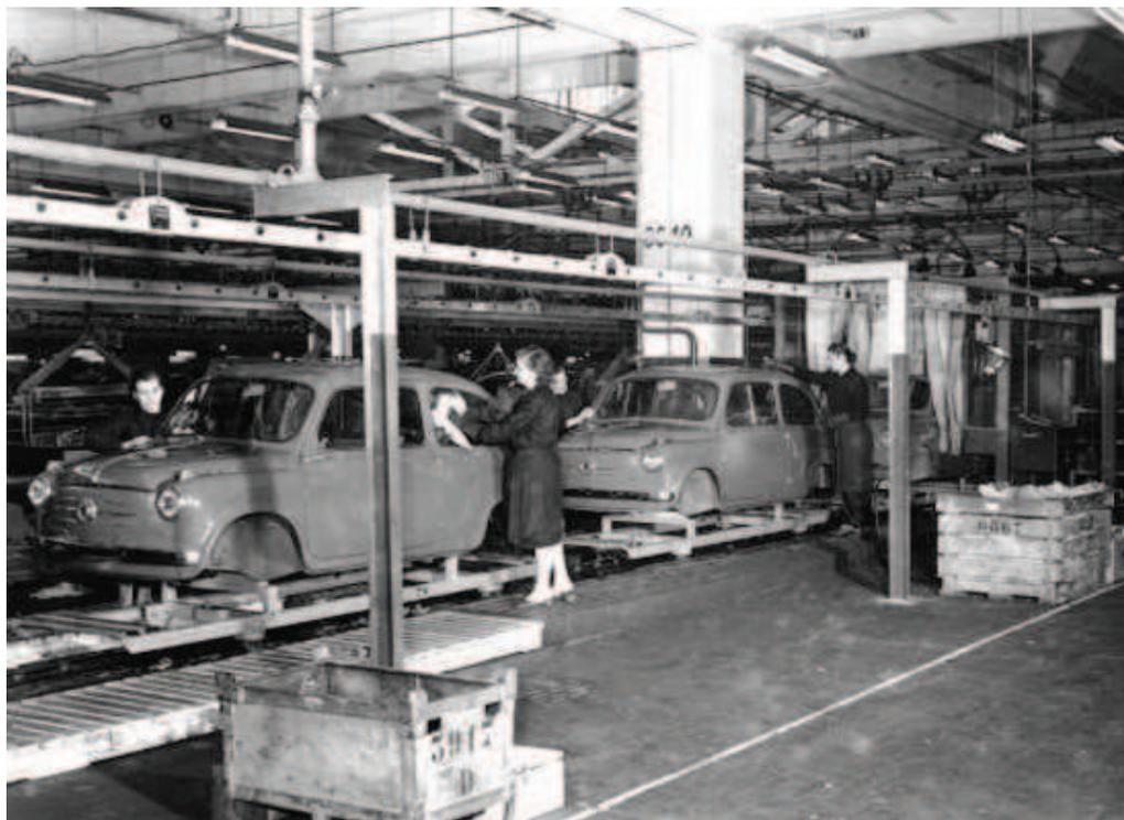
Fig. 7 Foto storica: catena di montaggio orizzontale all'interno dello stabilimento.
