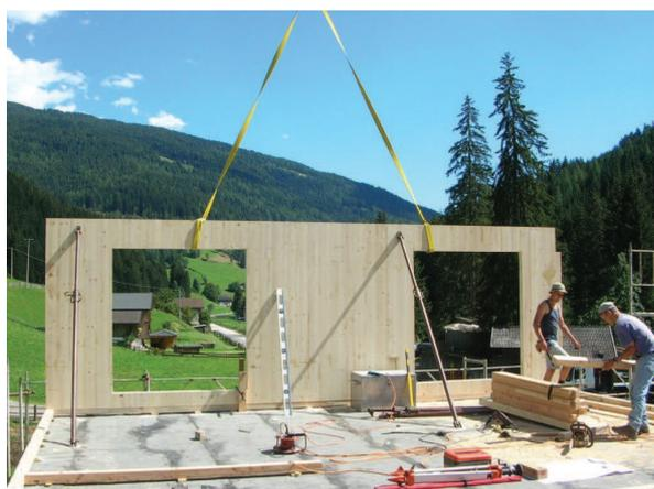
Fig.57: esempio di montaggio di pareti in X-lam.
