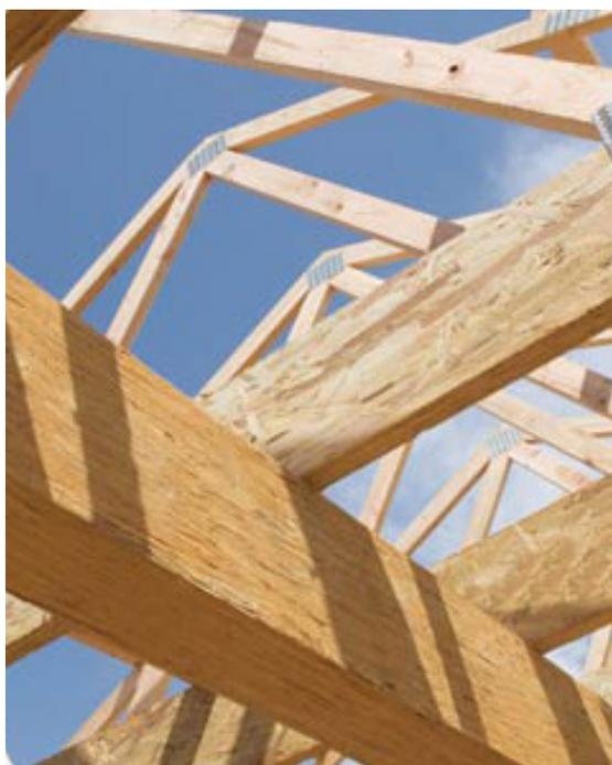
Figura 2.10 - Struttura a telaio in LSL
