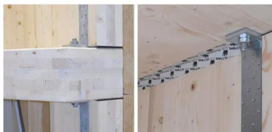
Figura 2.13 - Connessione tra pareti e solaio composti da pannelli in X-Lam.
