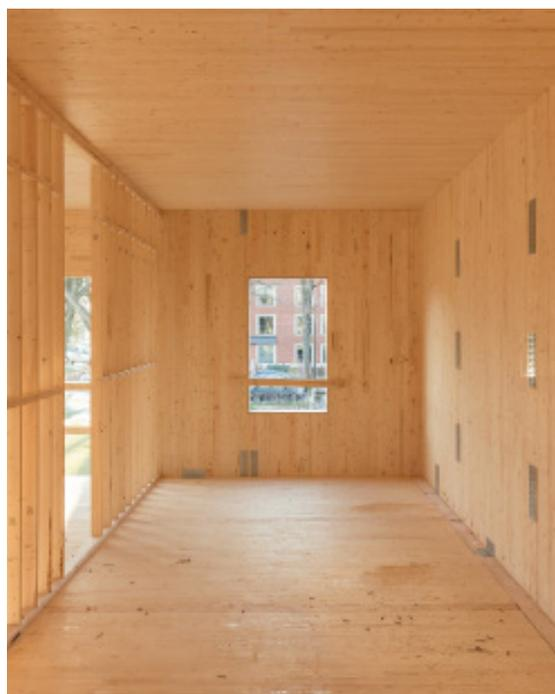
Figura 2.4 - Struttura in pannelli di compensato strutturale X-Lam
