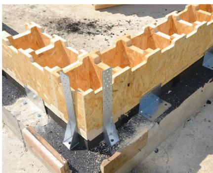
Figura 2.17 - Connessione alla fondazione
