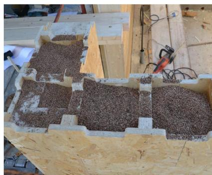
Figura 2.18 - Isolamento interno
