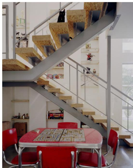
Figura 2.11 - Pedate in LSL con supporto di acciaio
