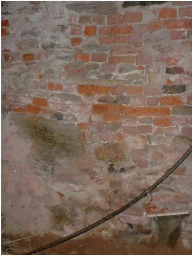
Per ogni campione di muratura esaminata, si è provveduto a scattare delle fotografie, in riferimento alle quali si è poi eseguito il rilievo dei conci compresi dalla maschera di misurazione. I campioni analizzati sono stati schedati e studiati per quanto concerne la percentuale di malta e di conci, il tipo di apparecchiatura, le dimensioni e la loro consistenza.
