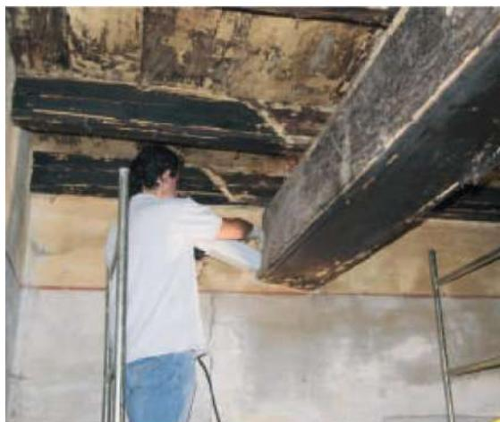
**Figura 56** – Perforazione sul lato sinistro della trave
