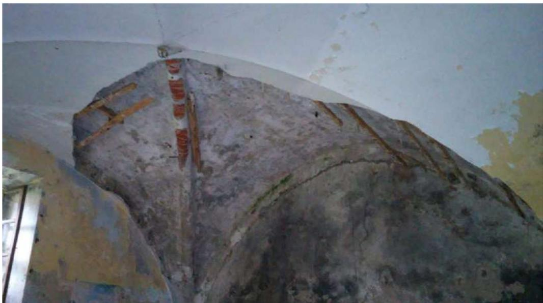
**Figura 224** - Vista della volta a crociera di un soffitto che ha ceduto al secondo piano della manica del loggiato. Ottobre 2016
