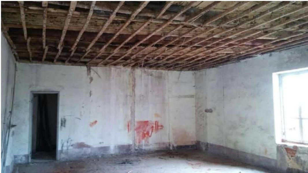
**Figura 43** -Trabeazione lignea di un soffitto degradato in una stanza del fabbricato più nuovo. Ottobre 2016
