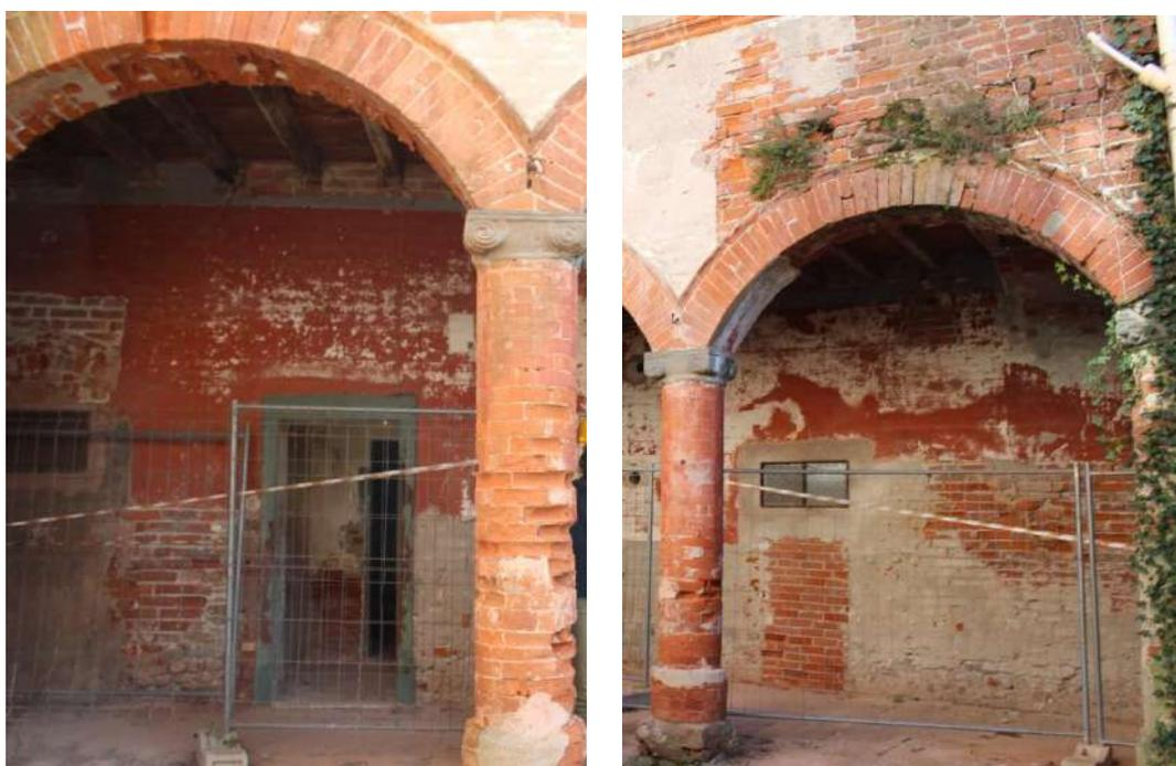
La facciata interna al loggiato del piano superiore invece si mostra meglio conservata: le pareti sono coperte da un intonaco di colore grigiastro e i mattoni a vista sono in quantità minore rispetto a quelli che si osservano al piano terra. Il parapetto del loggiato superiore risulta un po' danneggiato invece e vi sono mattoni mancanti e fortemente degradati.
