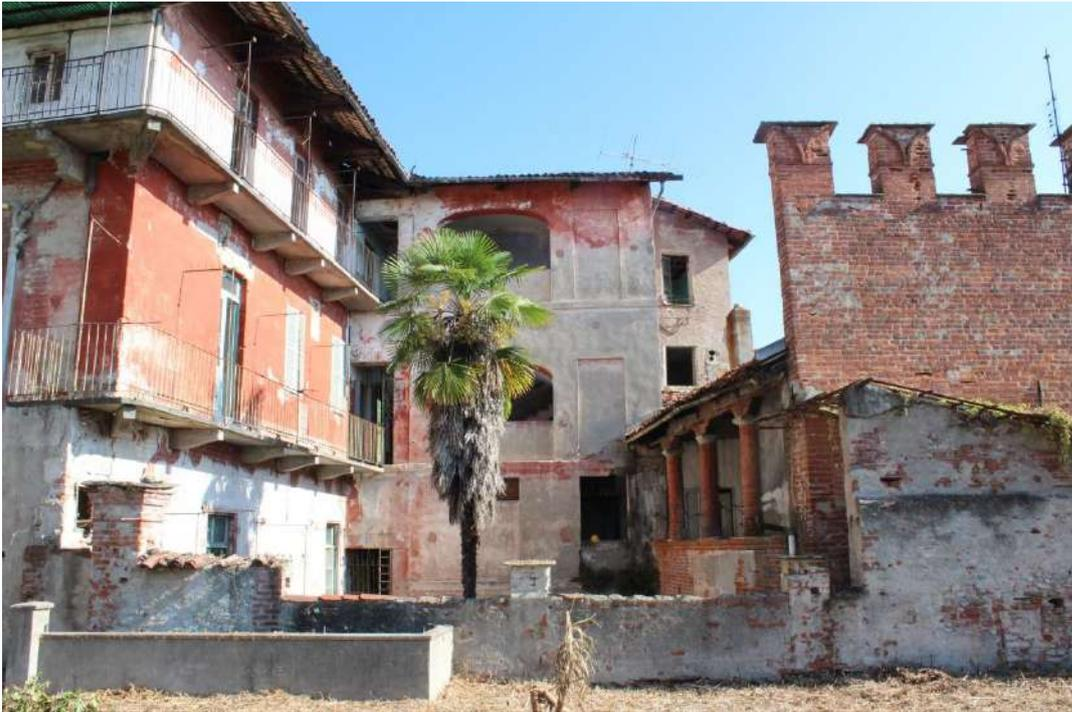
Il prospetto che affaccia sulla corte interna è quello meglio conservato, anche se presenta gli effetti del dilavamento dell'intonaco originario rosso, lasciando il posto a quello sottostante di colore biancastro. Si osservano alterazioni di colore e apposizioni. La parte superiore, sotto la copertura rivela parzialmente la tessitura in laterizio sottostante e sembra essere quella più degradata, in quanto soggetta ad umidità e infiltrazioni di acqua piovana dalla copertura ammalorata.
