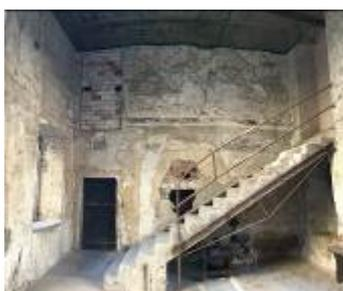
*Fotografia del locale 2: in primo piano la scala costruita a metà del XX secolo. In alto a sinistra un'apertura tamponata con mattoni forati.*
