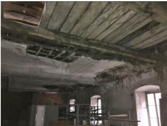
*Solaio dell'ultimo piano con gravi segni di cedimento.*
