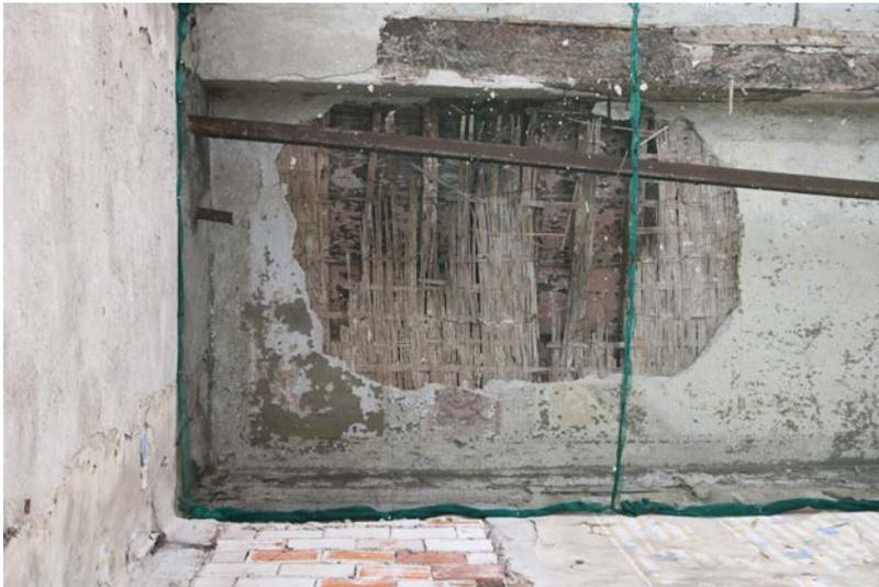
*Distacco dell'intonaco dal controsoffitto del solaio del primo piano (esterno): per proteggere i passanti dalla caduta di materiale è stata posizionata una rete di plastica verde.*
