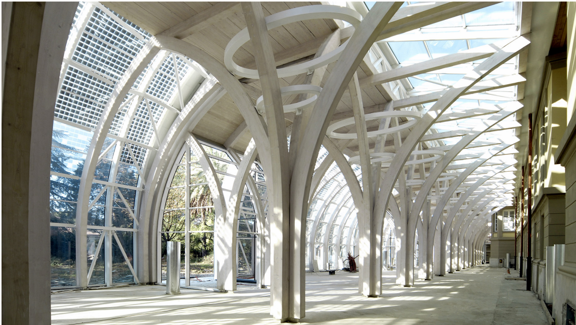
Figura 4. Azienda Ospedaliera Meyer. Serra bioclimatica in fase di costruzione
