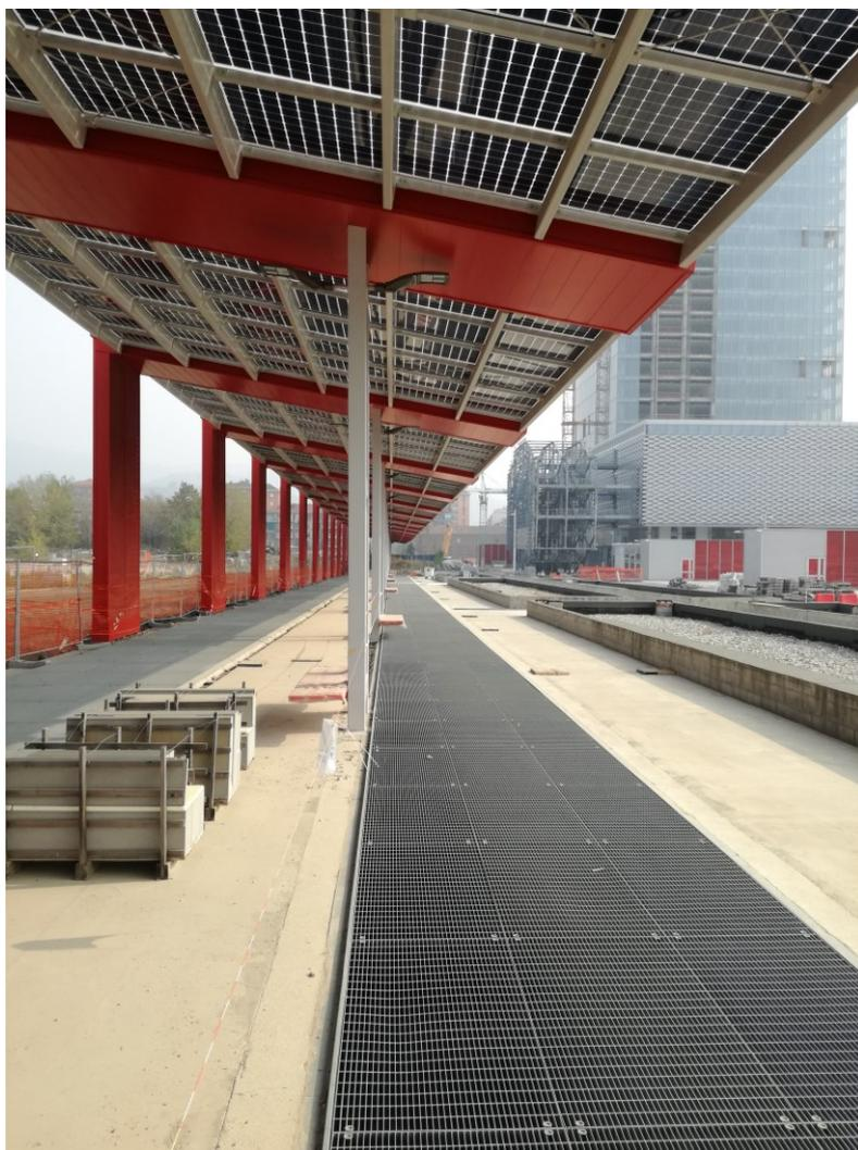
Foto in fase di cantiere della promenade e del centro servizi, dettaglio della presenza delle grate di aerazione dei parcheggi interrati, Federica Paonessa, 19 ottobre 2017.
