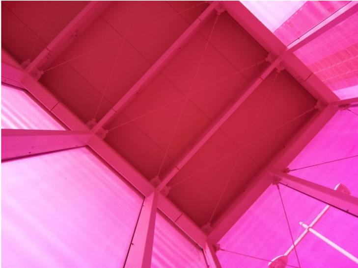
Foto in fase di cantiere dei blocchi scala sulla piazza, elementi prefabbricati in acciaio e policarbonato rosso, Federica Paonessa, 19 ottobre 2017
