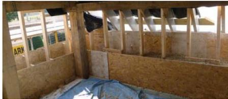
Fig 2.50 Sistema di cassetatura, primo livello (THB-Sparrow, Stanwix)
