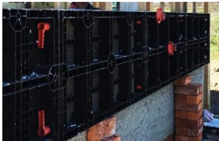
Fig 2.62 Geopanel con getto in canapulo e calce (Geoplast)
