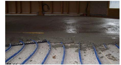
Fig 2.78 Posa del impianto di riscaldamento a pavimento (TechniChanvre)
