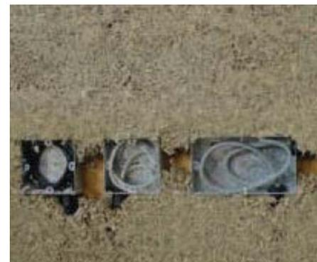
Fig 2.73 Scatole impianto elettrico annegate nel getto (THB-SS)
