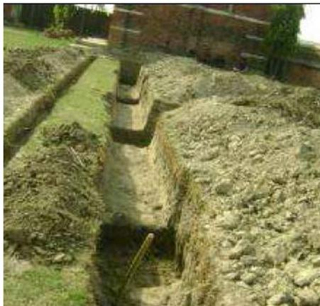
Fig 4.45-46 Scavo e compattazione suolo di fondazione (CSEB manual,Cord)
