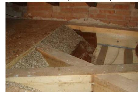
Fig 2.84 Isolamento solaio non calpestabile (Olver Zaccanti)
