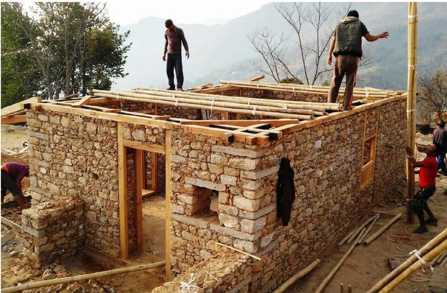
Fig 5.14 Realizzazione solaio intermedio (thekauleprototype)
