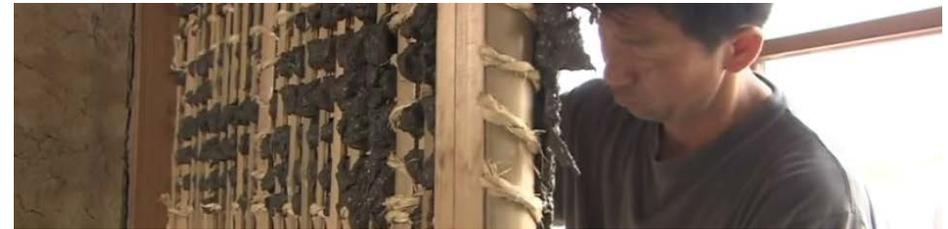
Fig 4.68 Posa della miscela in terra cruda sulla struttura di supporto (theyearofmud.com)
