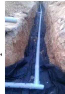
Fig 4.33 Sezione e posa tubo di areazione delle fondazioni di una casa in earthbag (DG vol ii)
