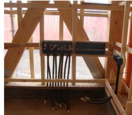
Fig 2.71 Predisposizione impianto elettrico (Olver Zaccanti)
