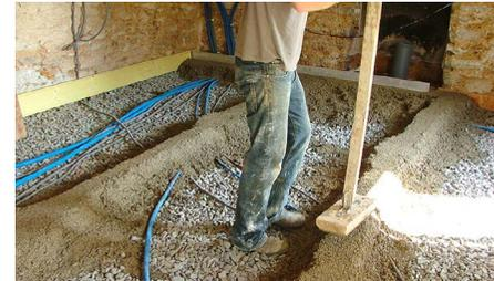
Fig 2.75 Getto guida per stabilire altezza massetto livello del getto (TechniChanvre)
