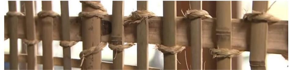
Fig 4.67 Griglia di supporto in bambù e corde in fibra naturale (theyearofmud.com)
