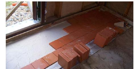
Fig 2.80 Posa del finitura pavimento (TechniChanvre)
