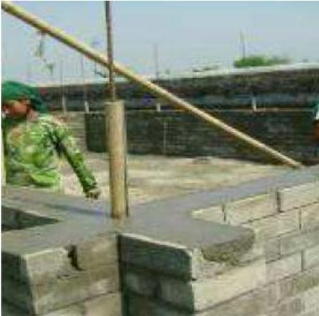
Fig 4.51-52 Cordolo intermedio di contenimento e montaggio telai aperture(CSEB manual,Cord)
