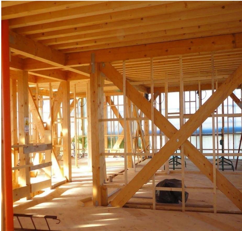
Fig 2.31 Struttura portante in legno trave-pilastro con croci di sant'andrea come controventi (Olver Zaccanti)
