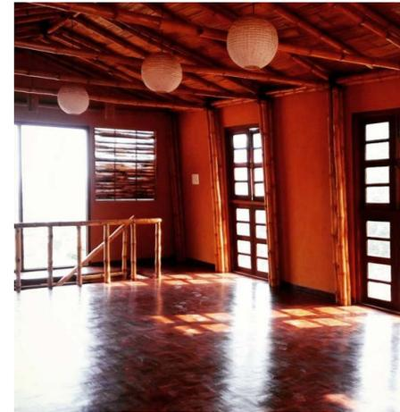
Fig 4.64-65 Primo edificio con telaio portante in bambù, Pharping, Nepal (ABARI.earth)
