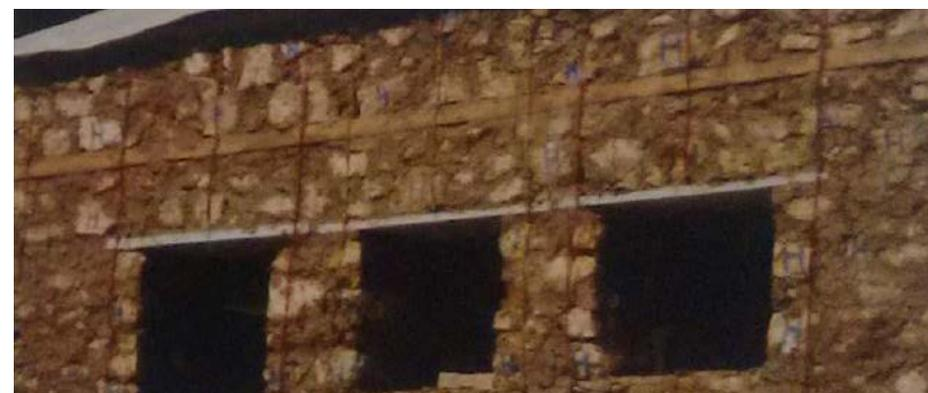
Fig 4.25 Elementi di collegamento verticali dei gabbioni di contenimento in rete metallica di una casa in pietra con muratura confinata da gabbioni in filo di ferro (manuale NCPDP)
