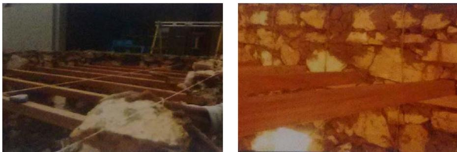
Fig 4.27-28 Dettagli montaggio solaio in una casa in pietra con muratura confinata da gabbioni in filo di ferro (Manuale NCPDP)
