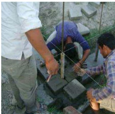
Fig 4.46-47 Realizzazione zoccolo e cordolo di fondazione (CSEB manual,Cord)
