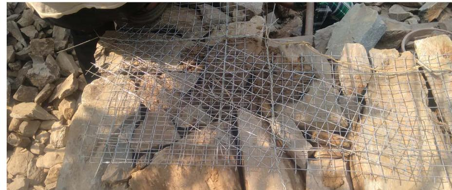
Fig 4.24 Dettaglio soluzione d'angolo delle fasce di contenimento in rete metallica di una casa in pietra con muratura confinata da gabbioni in filo di ferro, cantiere di training, Gorkha, Nepal
