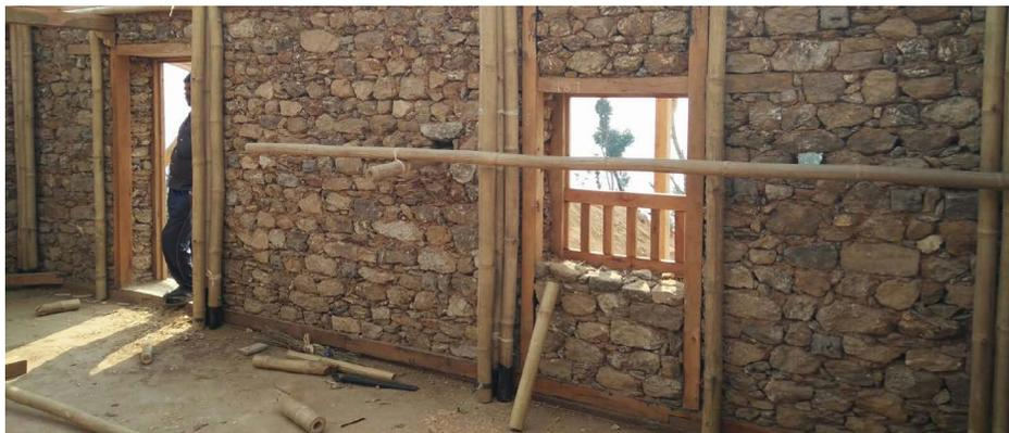
Fig 5.10 Muratura in pietra e telaio in bambù (thekauleprototype)
