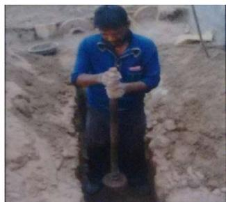
Fig 4.15 Buone pratiche del costruire una muratura in pietra non squadrata, compattazione suolo di fondazione con mazzeranga (Manuale NCPDP)
