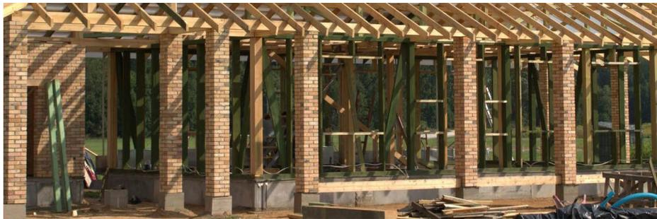
Fig 2.67 Struttura intelaiata con basamento in cemento armato HempEcoSystem
