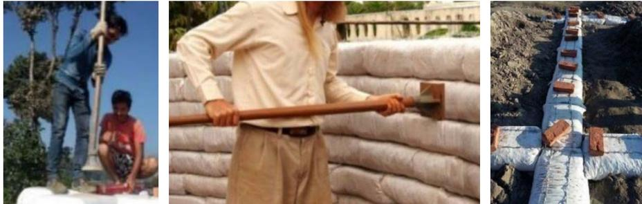
Fig 4.36-37-38 Compattazione e posa filo spinato (DG vol ii)
