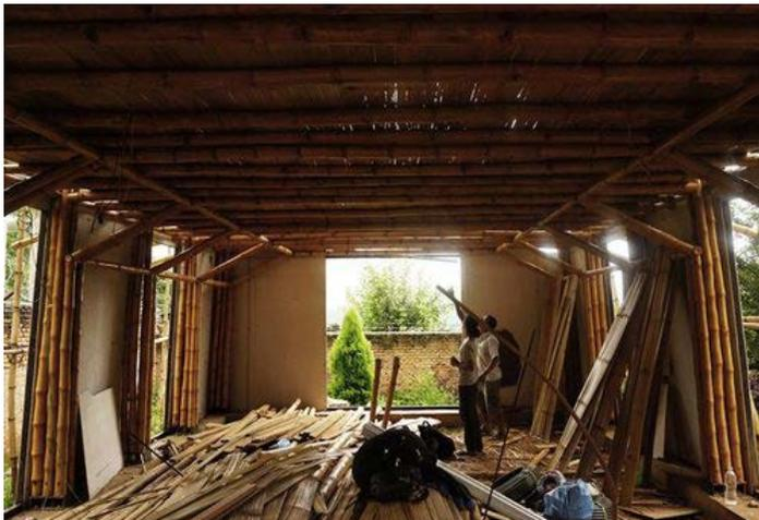
Fig 4.62 Primo edificio con telaio portante in bambù, Pharping, Nepal (ABARI.earth)
