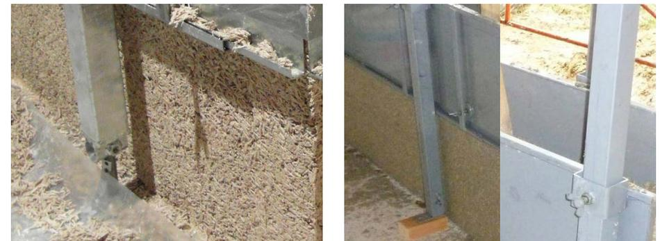
Fig 2.65-66 Sistema cassetta metallico, appoggio a terra e sistema di scorrimento dei casseri (HempEcoSystem)
