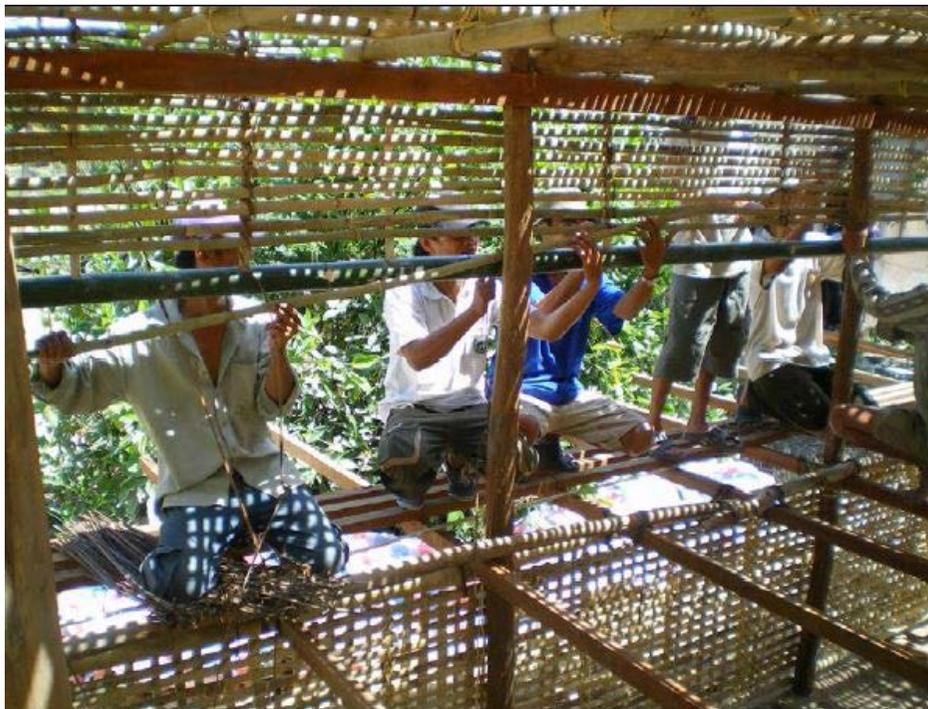
Fig 4.66 Realizzazione griglia di supporto in bambù (Kenji Matsuki)
