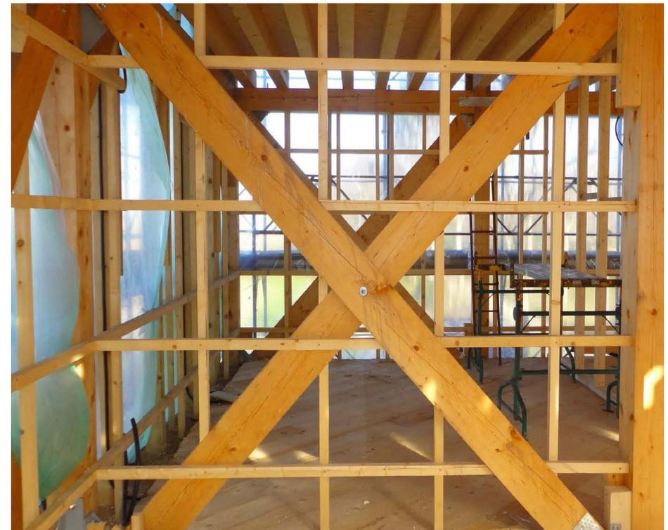
Fig 2.32 Griglia di collegamento tra la struttura e il getto in canapulo e calce (Olver Zaccanti)
