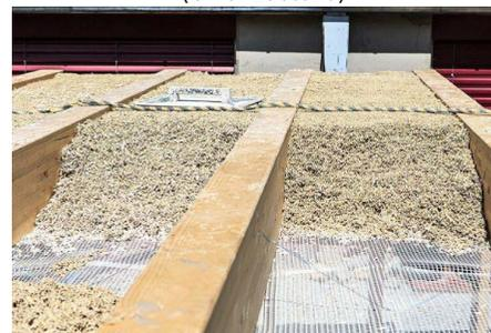
Fig 2.83 Sistema con rete di contenimento e filo di ferro (HempEcoSystem)
