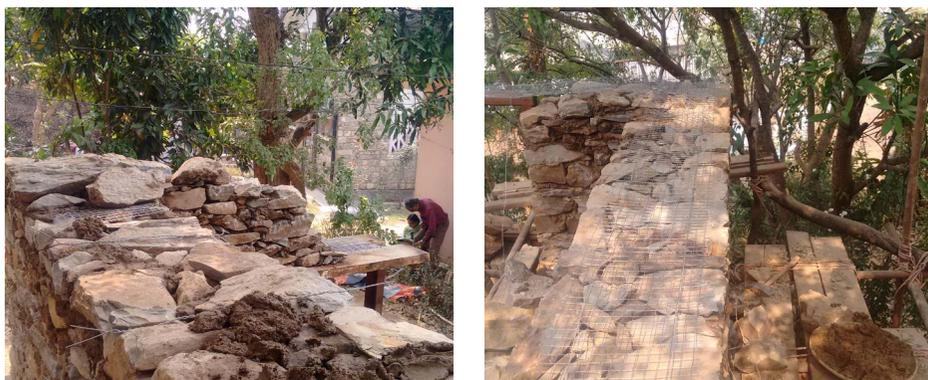
Fig 4.22-23 Dettagli delle fasce di contenimento in rete metallica e degli elementi di collegamento trasversale di una casa in pietra con muratura confinata da gabbioni in filo di ferro, cantiere di training, Gorkha, Nepal
