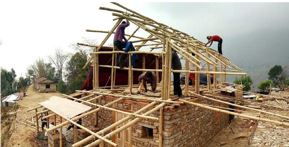
Fig 5.18 Realizzazione copertura (thekauleprototype)
