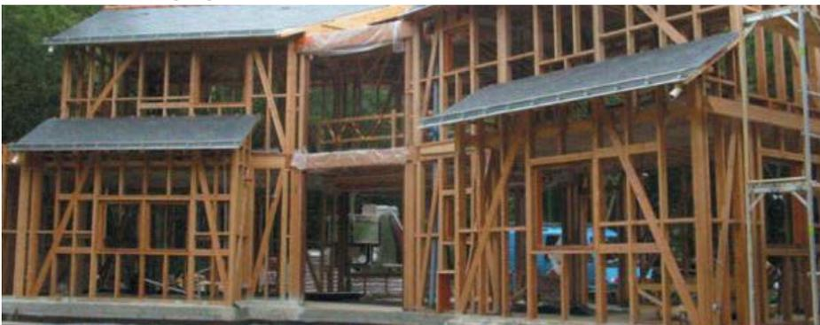
Fig 2.33 Struttura intelaiata con diagonali di collegamento (Building with hemp)
