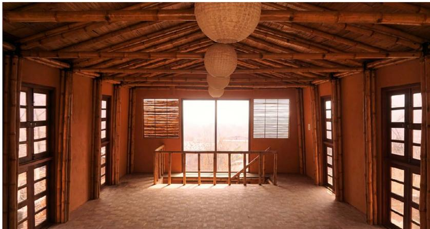
Fig 4.63 Primo edificio con telaio portante in bambù, Pharping, Nepal (ABARI.earth)
