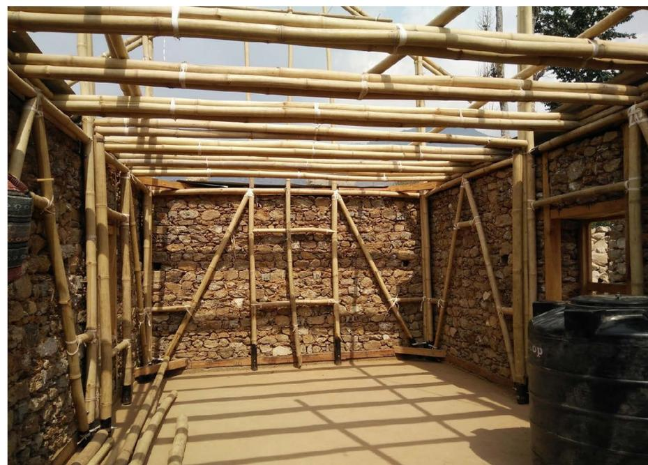
Fig 5.12 Muratura in pietra e telaio in bambù (thekauleprototype)
