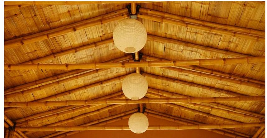
Fig 4.69 Copertura primo edificio con telaio portante in bambù, Pharping, Nepal (ABARI.earth)
