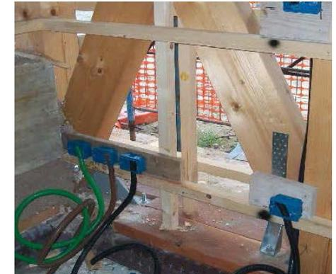
Fig 2.72 Predisposizione impianto elettrico (Olver Zaccanti)
