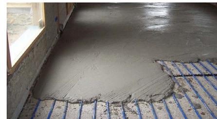
Fig 2.79 Posa del massetto di calce e sabbia (TechniChanvre)
