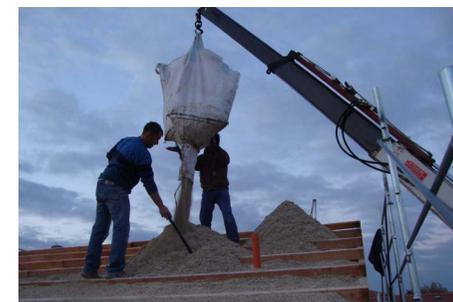
Fig 2.82 Posa della miscela su copertura a cassettoni (Olver Zaccanti)
