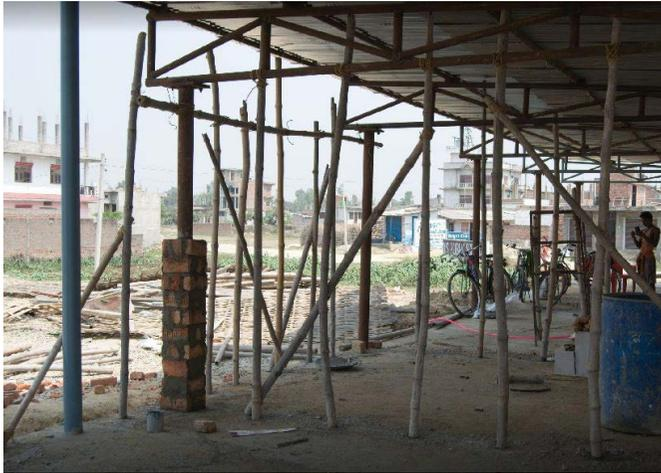
Fig 3.8 Struttura in bambù di collegamento alla struttura principale, cantiere sperimentale a Janakpur, Nepal (SHIV)
