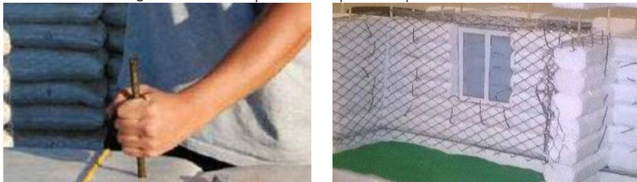
Fig 4.39-40 Installazione tondini metallici di rinforzo verticale e rete metallica porta intonaco (DG vol ii)
