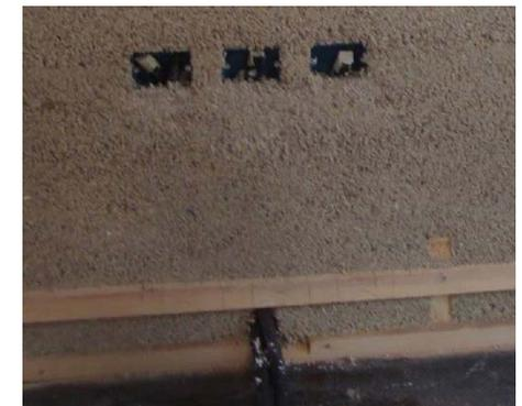
Fig 2.74 Scatole impianto elettrico annegate nel getto (O.Z.)
