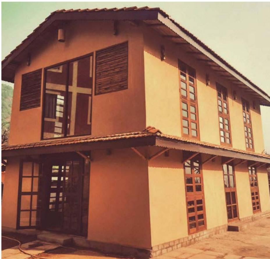
Fig 4.60 Primo edificio con telaio portante in bambù, Pharping, Nepal (ABARI.earth)
