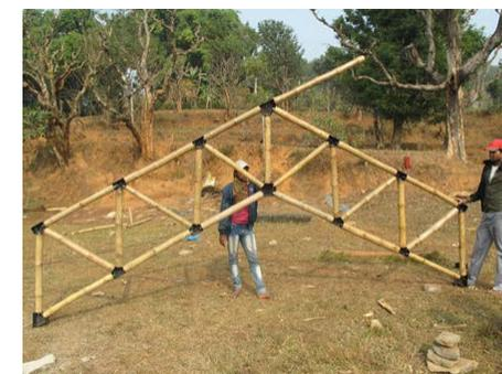
Fig 5.5 Giunti metallici prodotti in nepal per trave reticolare in bambù (ABARI.earth)
