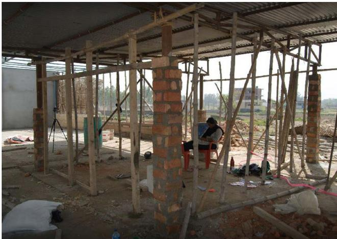
Fig 3.9 Rivestimento in mattoni dei pilastri in ferro, cantiere sperimentale a Janakpur, Nepal (SHIV)
