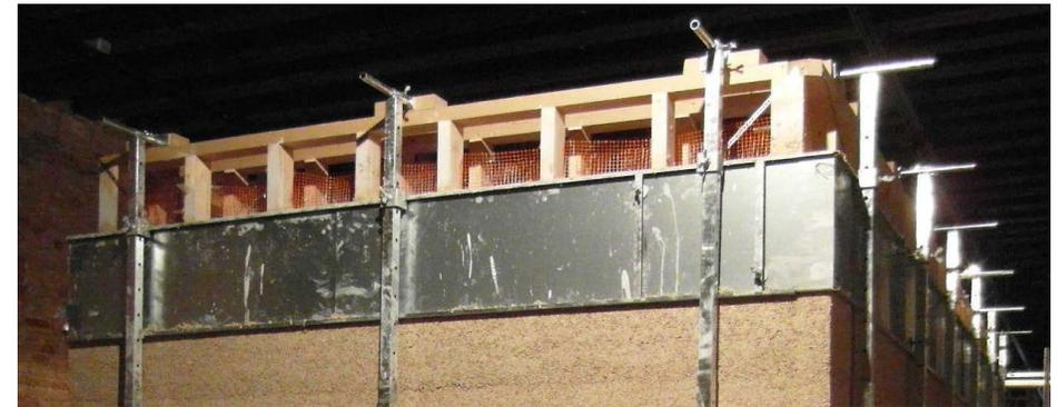
Fig 2.64 Sistema cassetta metallico ammortato al cordolo superiore (HempEcoSystem)
