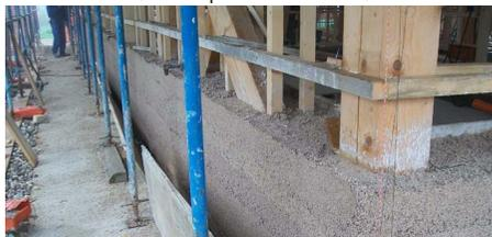
Fig 2.53 Scasseratura primo livello (Olver Zaccanti)
