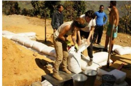
Fig 4.35 Posa dei sacchi di earthbag (DG vol ii)
