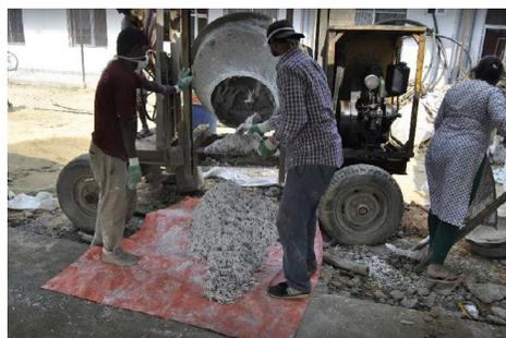
Fig 3.6 Miscelazione con betoniera, cantiere sperimentale a Janakpur, Nepal (SHIV)
