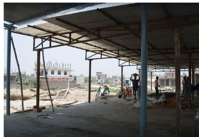
Fig 3.6 La struttura prefabbricata pre-esistente, cantiere sperimentale a Janakpur, Nepal (SHIV)
