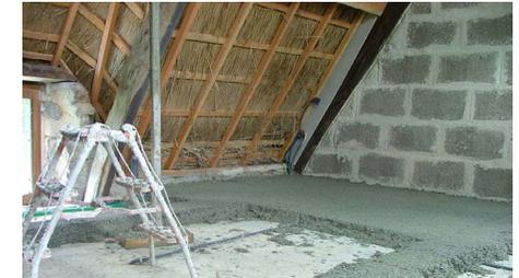
Fig 2.76 Getto guida per stabilire altezza massetto livello del getto (TechniChanvre)
