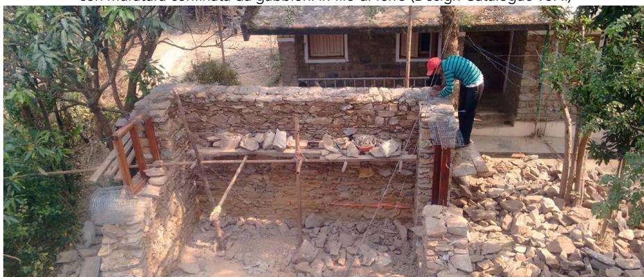
Fig 4.21 Posa delle fasce di contenimento in rete metallica di una casa in pietra con muratura confinata da gabbioni in filo di ferro, cantiere di training, Gorkha, Nepal
