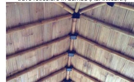
Fig 5.7 Dettaglio giunti metallici prodotti in nepal per coperture in bambù (ABARI.earth)
