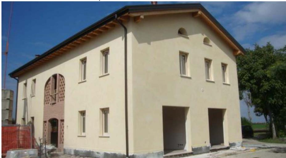
Fig 2.29 Edificio ricostruito col getto in canapulo e calce in seguito al terremoto che ha colpito l'emilia nel 2012 (Olver Zaccanti)
