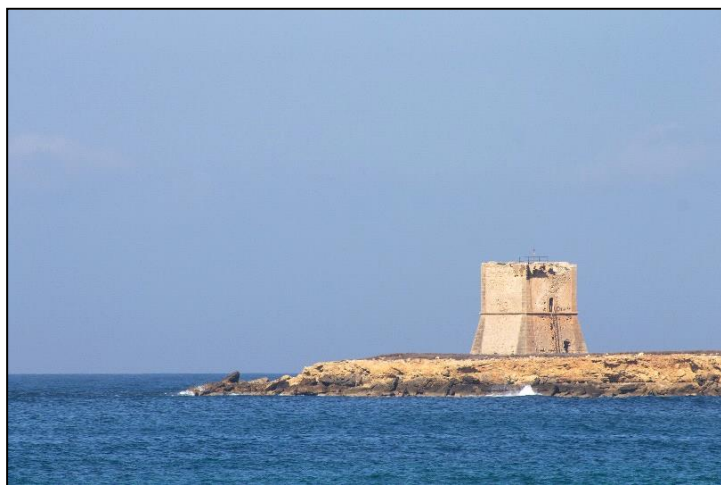
Figura 26 – Torre Molinazzo, Cinisi (Fotografia di Massimiliano Cataldo)
