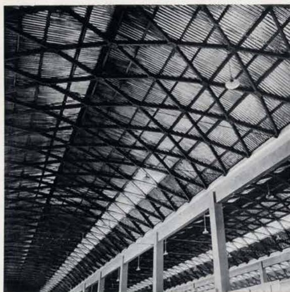
La lamiera di alluminio leggera, resistente ed inalterabile è un ottimo materiale per l'esecuzione di coperture e pareti di chiusura esterna.
