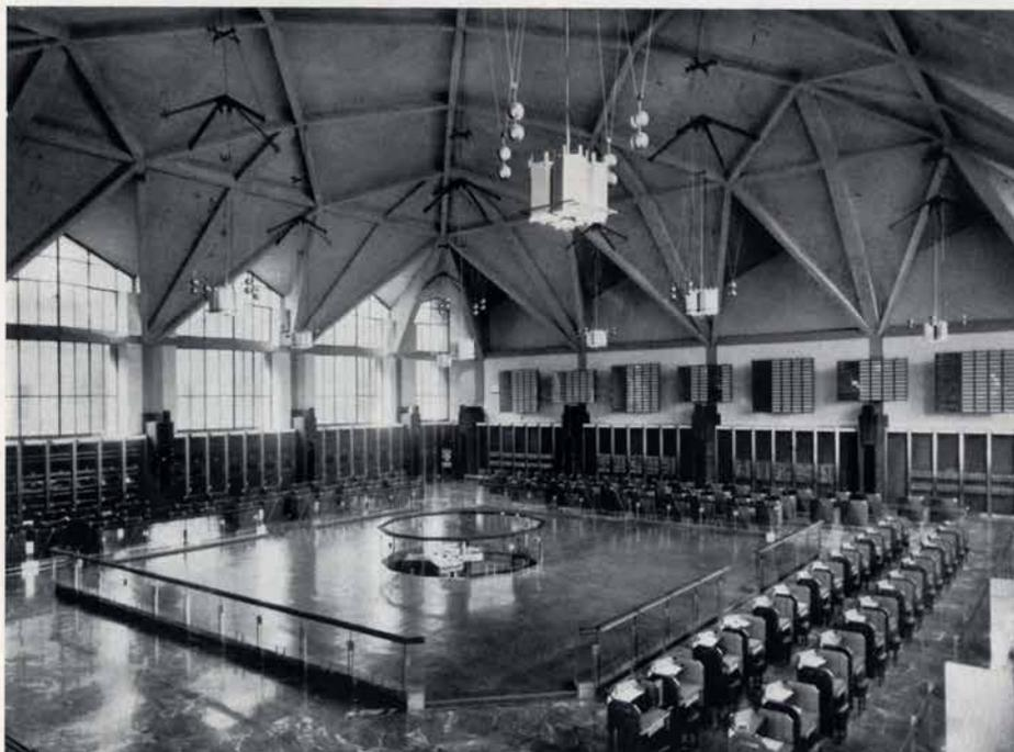
*Borsa Valori di Torino, progetto Arch. Gabetti-Isola-Raineri. La copertura dell'edificio è realizzata con volte sottili e cemento armato precompresso (sistema Dywidag).*
