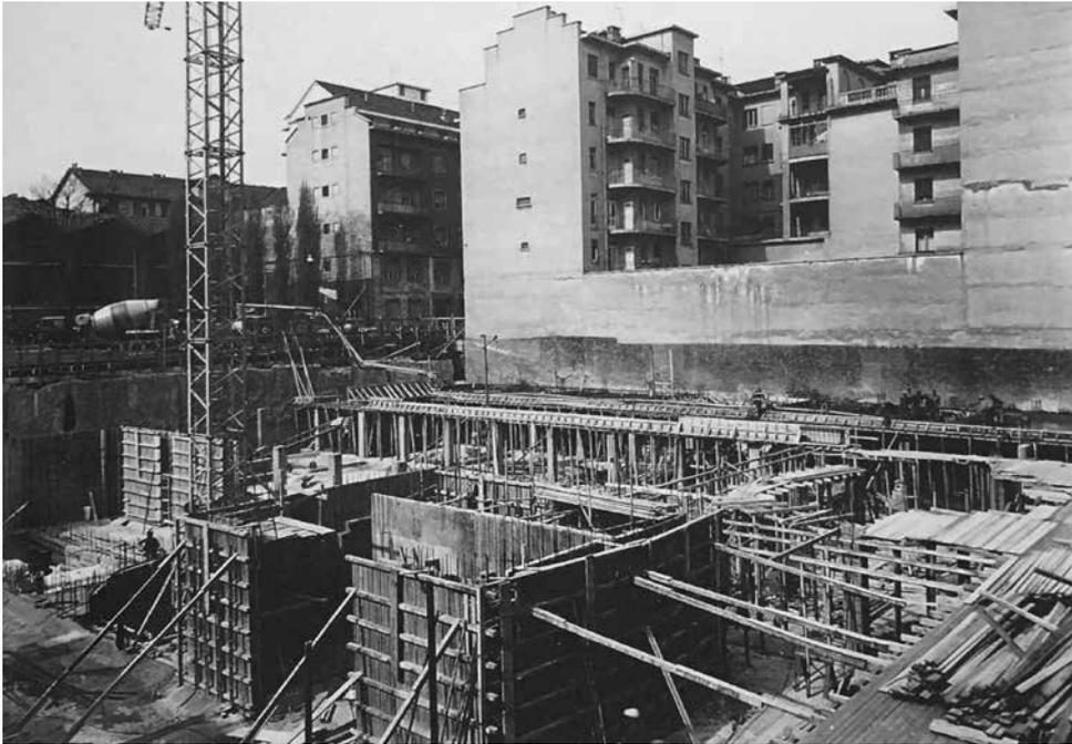
Il cantiere di Palazzo Affari in data 17 aprile 1970: completamento delle strutture interrante in primo piano il nucleo centrale della scala e dei vani per gli ascensori,
