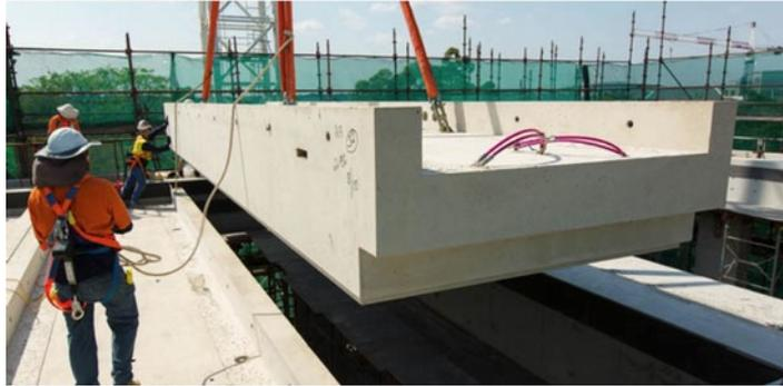
**Figura 1.23:** Travi prefabbricate impiegate nella realizzazione del GCI. (Fonte:www.geopolymer.org).
