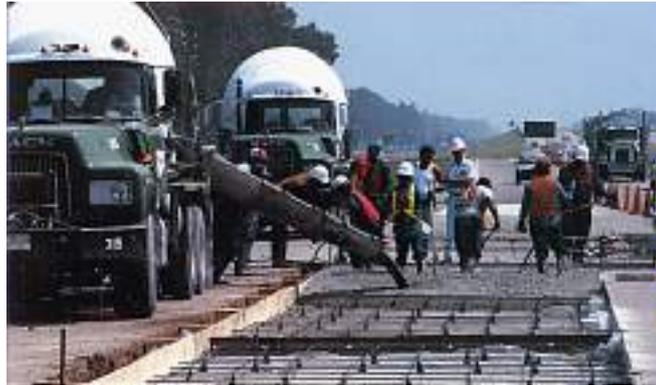
**Figura 1.20:** Lavori di riparazione di una strada con cemento Pyrament®. (Fonte: [www.geopolymer.org](http://www.geopolymer.org)).
