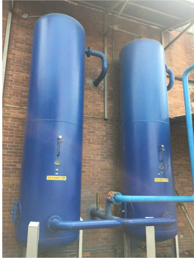
**Fig. 22: Foto serbatoi d'aria compressa**
