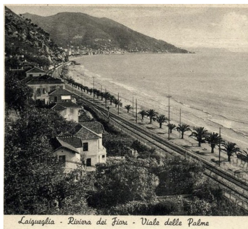
Fig. 6 Fotografie storiche della linea ferroviaria Genova-Ventimiglia passante lungo la linea di costa: il percorso lungo la costa e la stazione di Laigueglia (SV) (Fonte: www.marklinfan.com)
