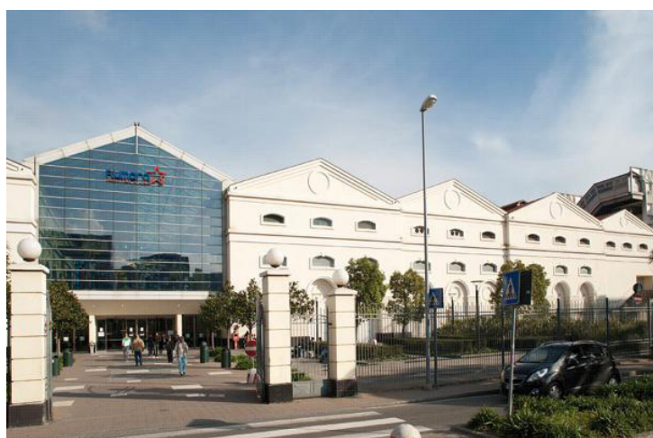
Fig. 21 Ex complesso industriale Tardy e Benech (Genova), oggi centro commerciale Fiumara. (Fonte: http://www.ponenteoggi.it/categorie/leggi-articolo/argomento/cultura/articolo/genova )
