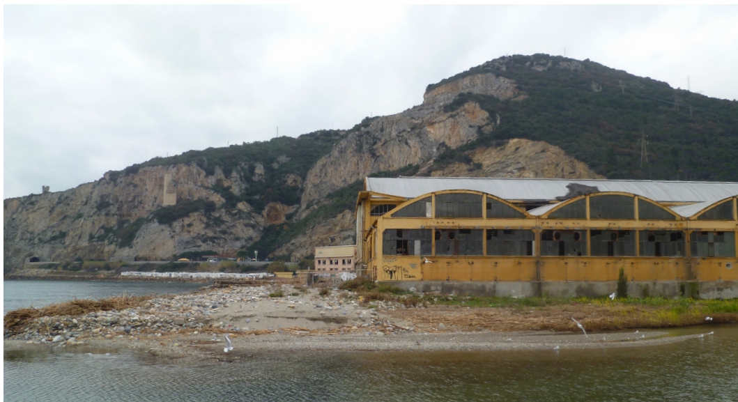
Fig. 1 Fotografia scattata durante il sopralluogo del 27/01/2017, fronte est, hangar sperimentale del complesso ex Officine Piaggio.
