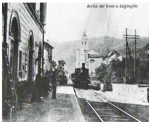
Fig. 7 Fotografie storiche della linea ferroviaria Genova-Ventimiglia passante lungo la linea di costa: il percorso lungo la costa e la stazione di Laigueglia (SV) (Fonte: www.marklinfan.com )
