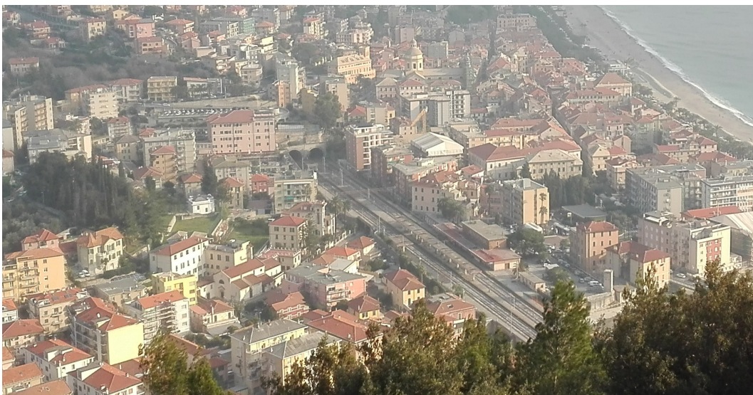
Fig. 8 Fotografia personale della linea ferroviaria che attraverso l’abitato di Finale Ligure, dal promontorio Caprazzoppa.
