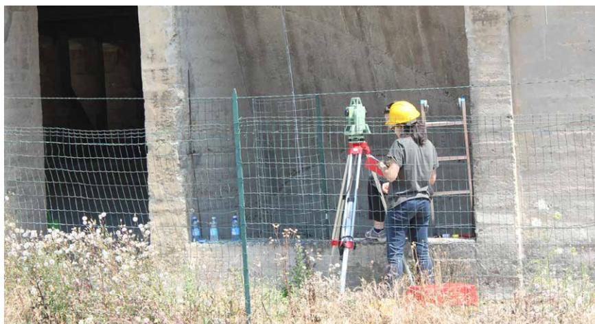
**Figura 1** - Stazione totale durante una misurazione verso il corridoio interrato.
