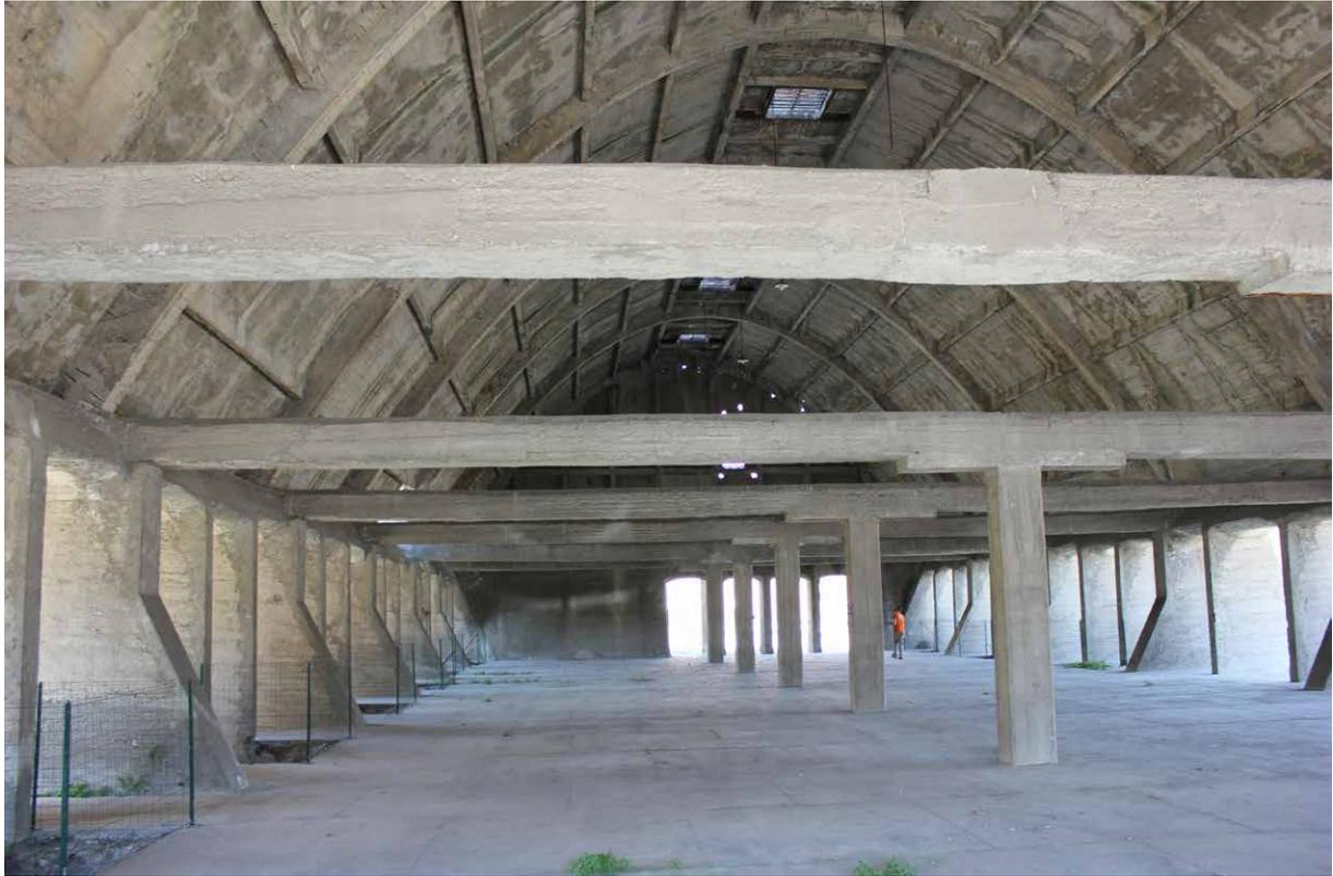
**Figura 13** - *Interno del paraboloide, visibili le strutture trave-pilastro aggiunte in un secondo momento.*
