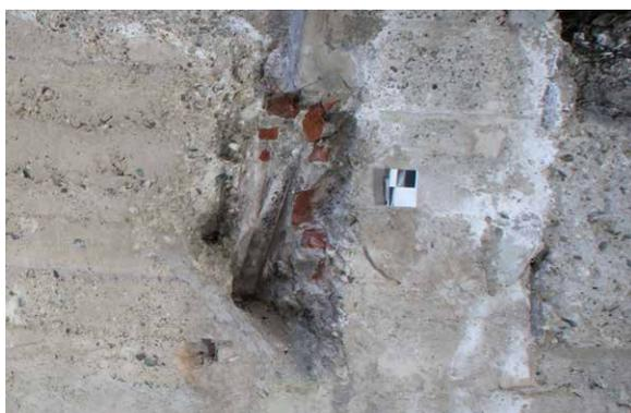
**Figura 15** - Distacco di materiale con esposizione strato sottostante di laterizi.
