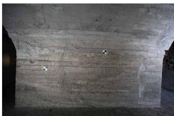
**Figura 45** - Esempio di marker apposti sulle pareti per consentire una più precisa elaborazione e la georeferenziazione.
