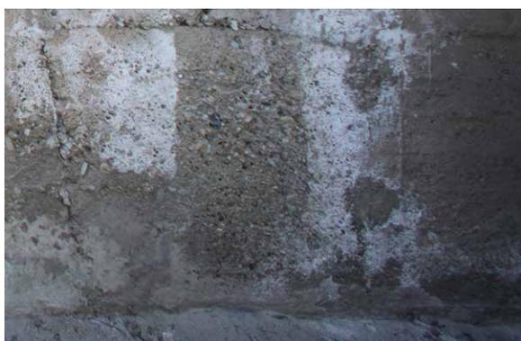
**Figura 17** - Efflorescenze ed effetti dell'umidità.
