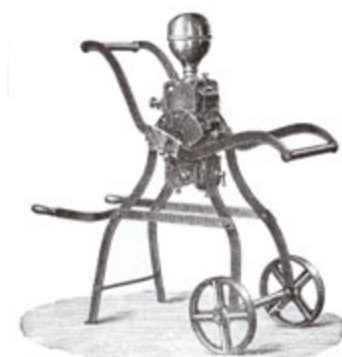
(e) Pompa oscillante Roller per il travaso
