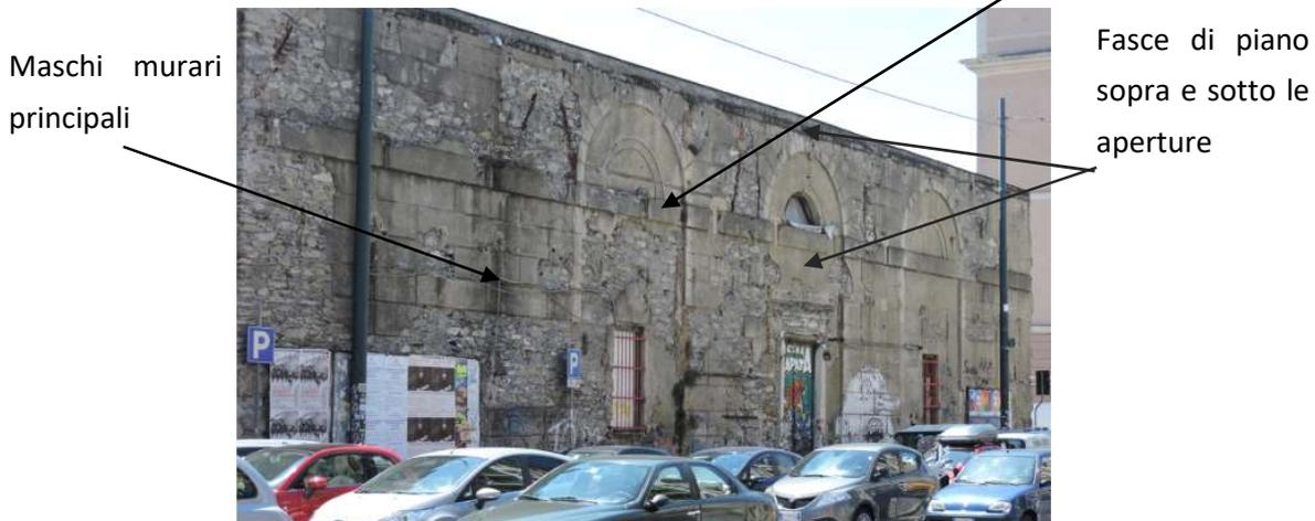
Figura 28. Esempio della schematizzazione delle murature dei Magazzini del Sale
