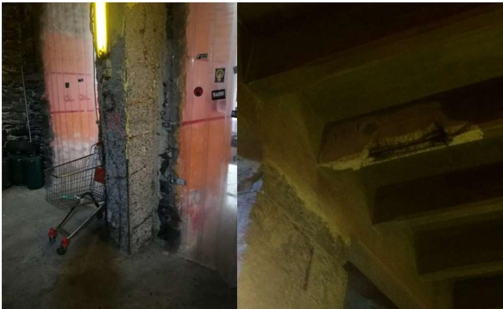
Figura 19. Degrado del calcestruzzo nella zona ovest dell'edificio. A destra assenza totale di copriferro in un pilastro ausiliario in CA. A sinistra mancanza di copriferro in una zona terminale di una trave del solaio intermedio che ospita la palestra di pugilato.
