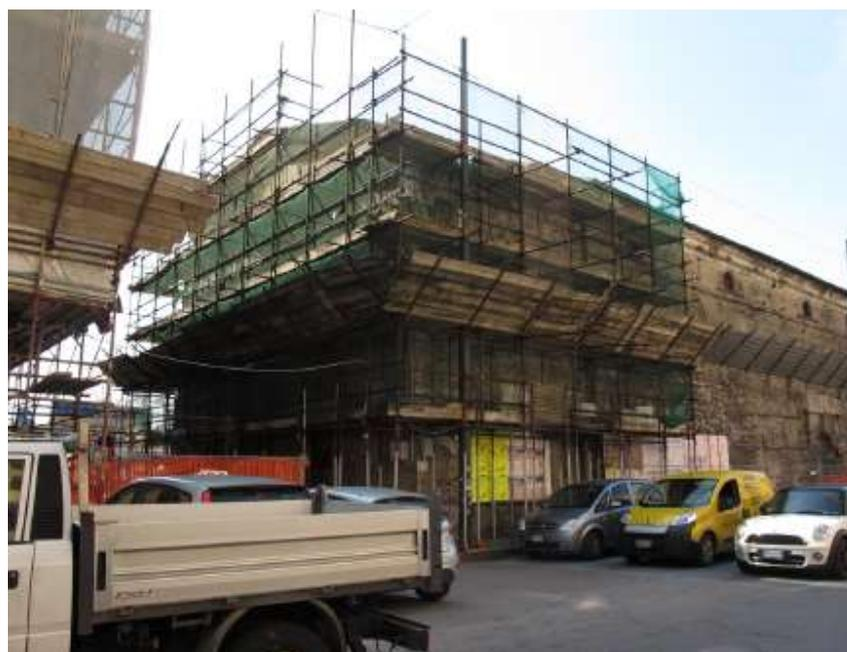
Figura 10. Porzione crollata e sorretta da un'impalcatura nel corpo est dell'edificio
