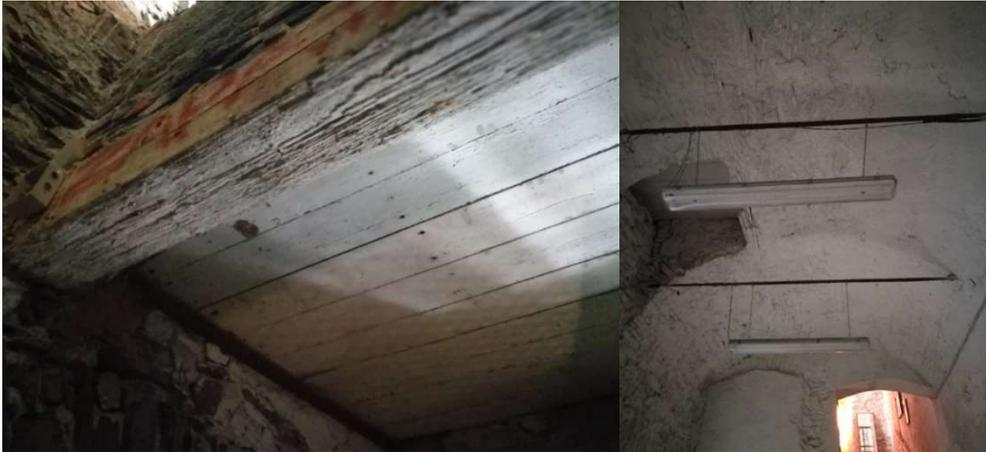
Figura 17. Elementi strutturali dei vani scala. A sinistra la struttura lignea del corpo scala e suo ancoraggio alla muratura. A destra il solaio voltato dell'ingresso in cui risaltano una bucatura e la presenza di catene
