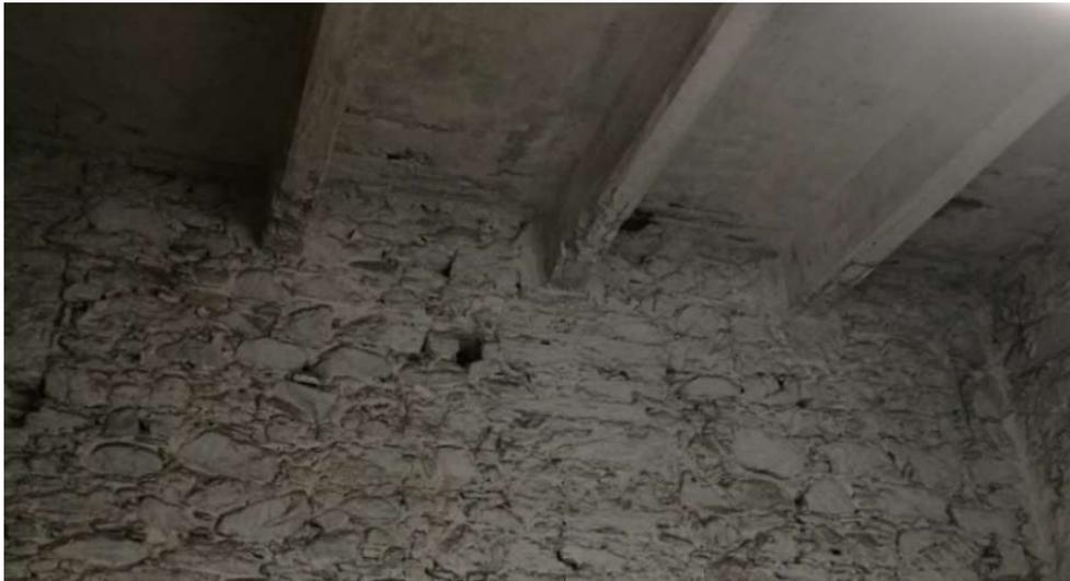
Figura 20. Particolare dell'ancoraggio del solaio intermedio che ospita la sala da ballo della bocciofila alla muratura. Si può notare il degrado degli elementi in CA nelle zone terminali delle travi e del solaio
