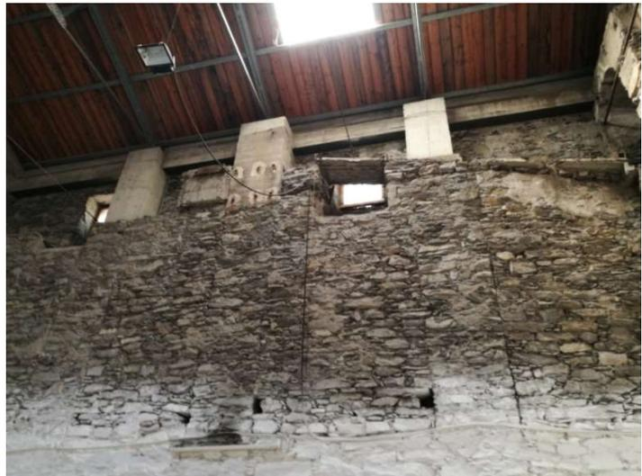
*Figura 15. Pilastri in cemento armato del corpo est e del corpo centrale inglobati nella muratura*
