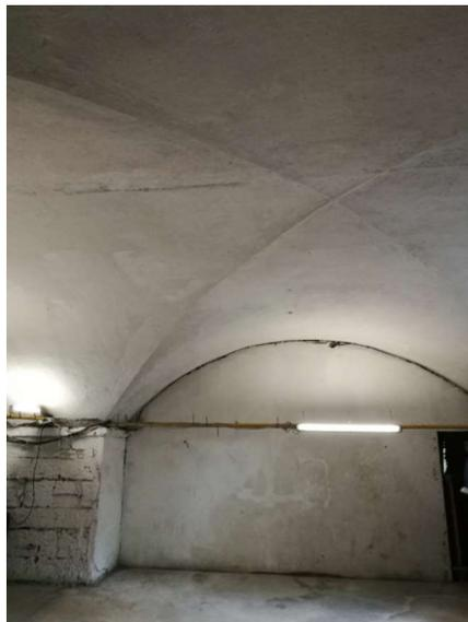
Figura 18. Solaio voltato di copertura del corpo ovest
