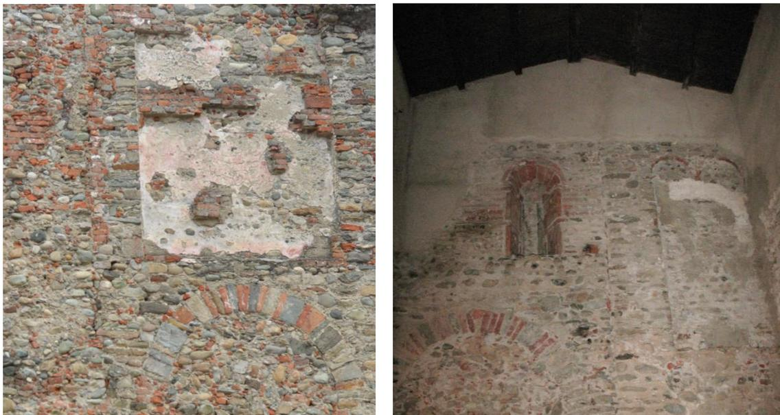
Figura 14: Arco a sesto rialzato e affresco al di sopra del portale di ingresso (a sinistra) e finestra monofora cieca e impronta della coppia di specchiature con archetti pensili binati nella controfacciata (a destra).
