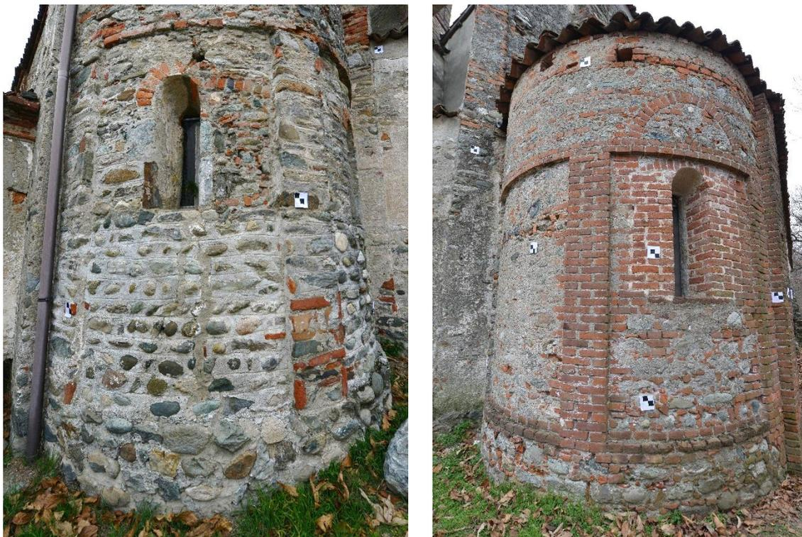
Figura 18: Operazione di rigatura nell'abside sud (a sinistra), lesena e monofora dell'abside nord.
