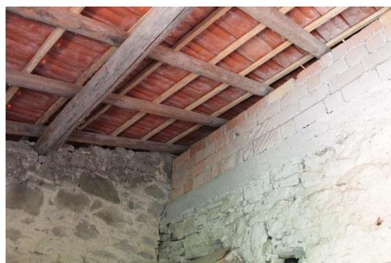
*Figura 2.3.1-Presenza di materiali incongrui per la riparazione della copertura*
