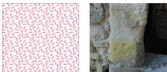
Figura 3.3.2-Il simbolo grafico ed il richiamo fotografico del Disgregazione
