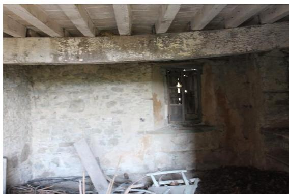
*Figura 2.2.1- Trave soggetta a infiltrazioni di acqua e presenza di umidità, Trave principale lesionata per eccesso di carico*
