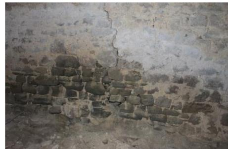
Figura 2.4.1-Lesioni derivati da sovraccarico
