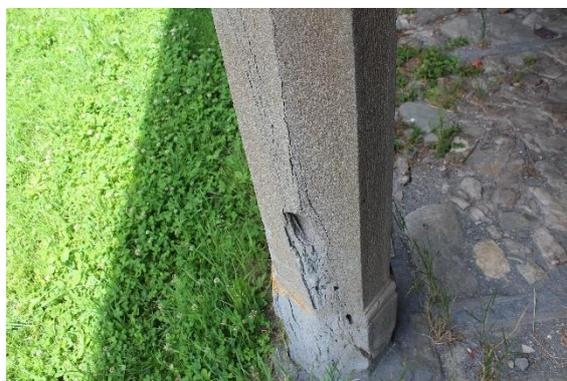
Figura 3.1.2- Distacco e Disgregazione
