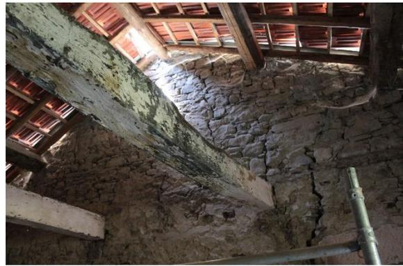
Figura 2.3.2- Presenza di un cordolo in Calcestruzzo Armato, Lesioni riportati alla muratura per effetto di sovraccarico della copertura
