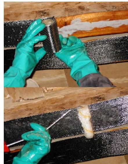
Figura 6.2.14 - Applicazione del rinforzo in fibre di carbonio. Fonte img.: <http://web.tiscali.it/taesr/legno01.htm>
