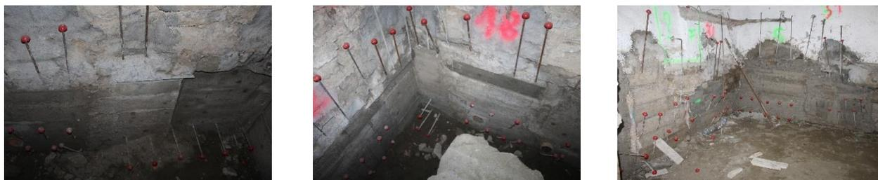
Figura 6.2.10 - Foto scattate durante il consolidamento in cantiere
