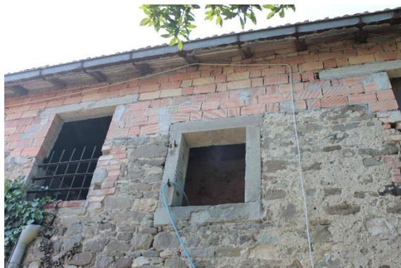
Figura 2.4.2-Fessurazione in corrispondenza delle modifiche nel tempo, Presenza di materiali incngui per riparare i danni della muratura perimetrale
