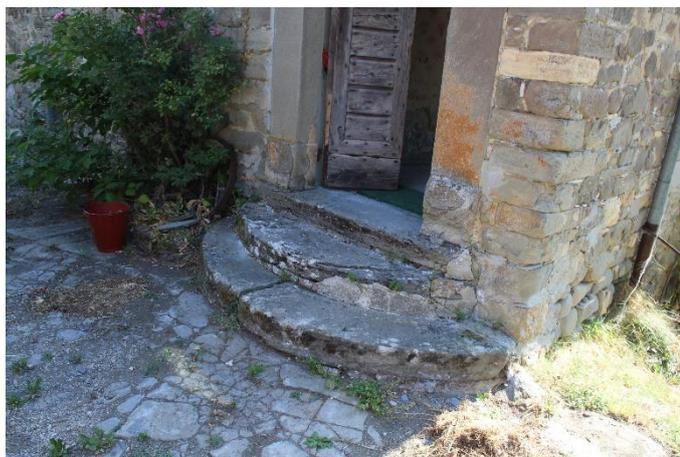
Figura 3.1.3-Le scale dell'ingresso principale, si evidenzia la presenza di muffe ed alghe in corrispondenza delle scale, e la presenza di licheni in corrispondenza della parte bassa del portale
