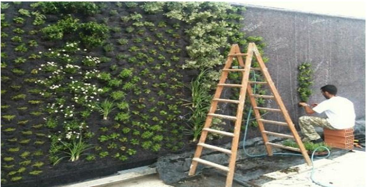
Figura 5: piantumazione manuale tra i due strati di feltro.
