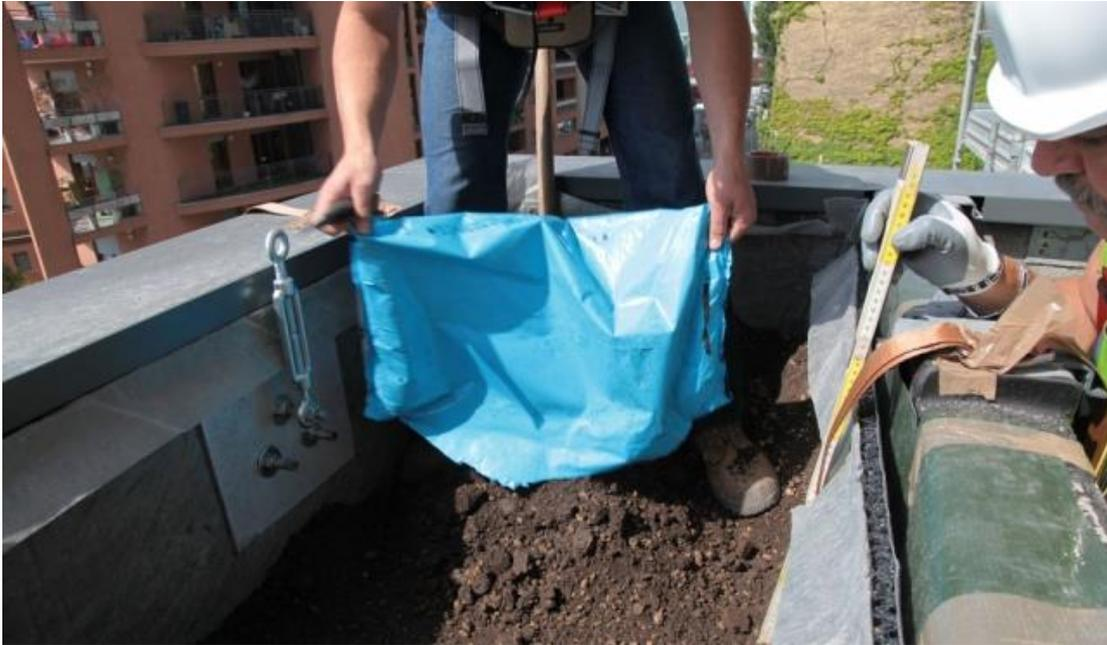
Figura 28: posa del substrato. Si notano anche gli elementi di ancoraggio.
